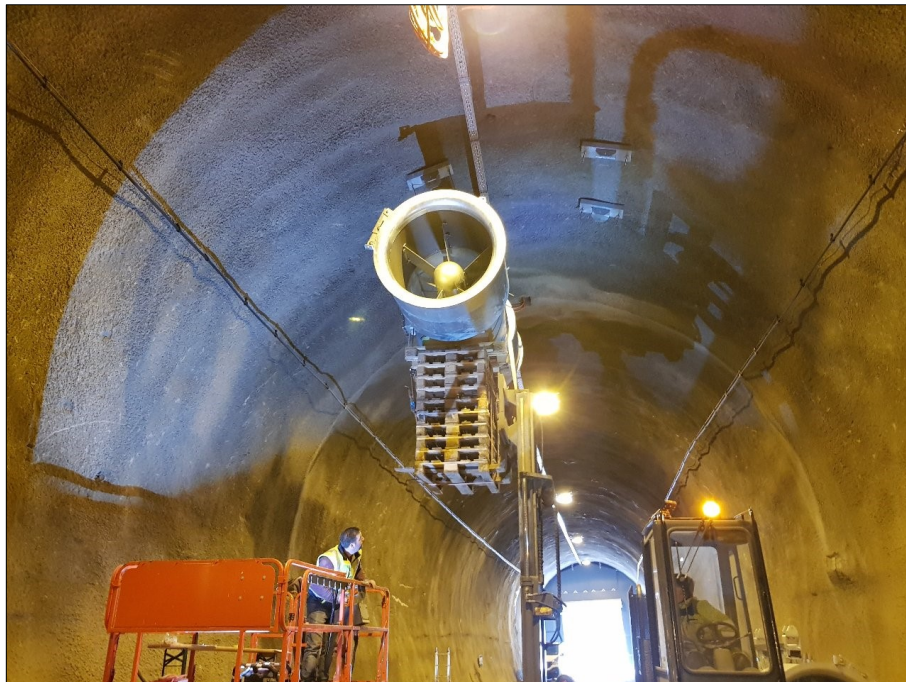
Abb. 5-4: Anheben eines Ventilators mittels Stapler
