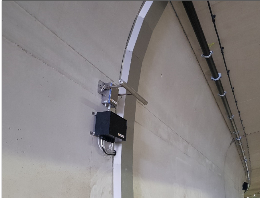
Abb. 6-1: Staudruckrohr LG-2020 (IAG)
