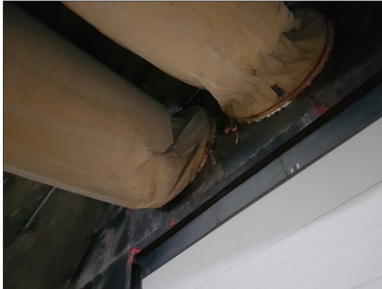
Abb. 7-13: Anschluss der Lutte an die Wetterwand
