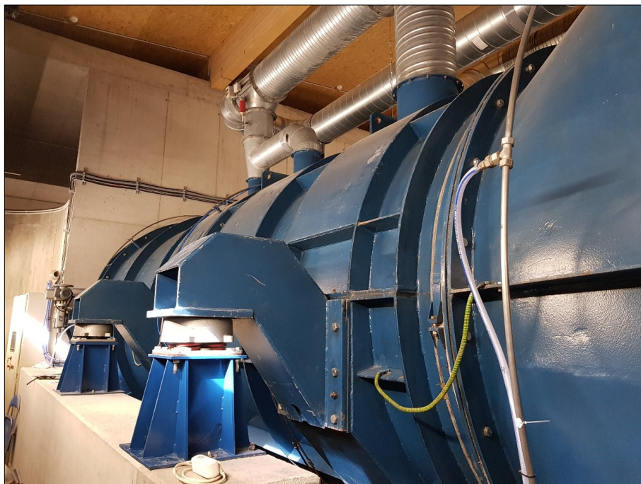
Abb. 5-8: Axialventilator 2
