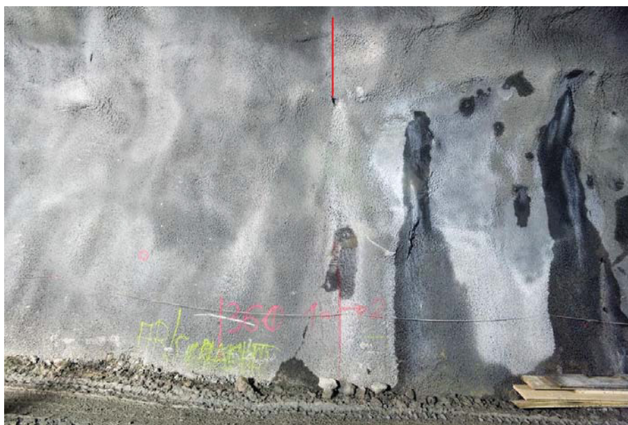
Bild 13: Ulmenbereich mit kleinflächiger Anwendung: modifizierter Spritzbeton (links) und Referenzspritzbeton (rechts)
