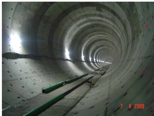
Abb. 9: Verlegung der Sohl drainage für Leckagewasser, Quelle: ÖBA H3-4
