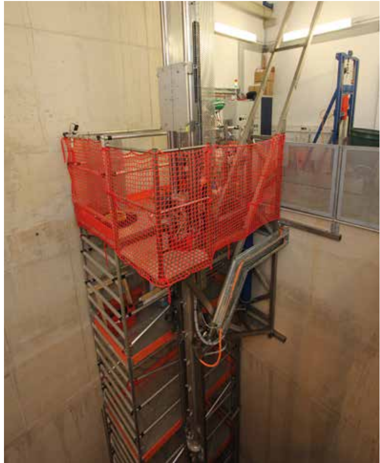
Der Pumpenteststand im Untergeschoß des Impulsentrums für Rohstoffe
