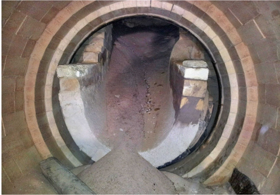
Abbildung 34: Blick vom Einlauf Kühlrohr zum Ofenauslauf bei einem Wartungsstillstand
