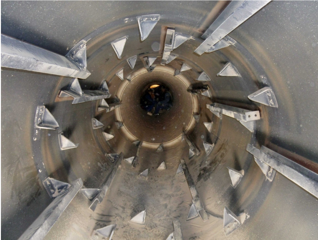
Abbildung 18: Blick in den Rotationskühler bei einem Wartungsstillstand
