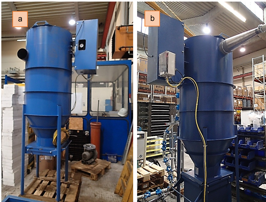
Abbildung 3.10: Jetfilteranlage nach dem Aufstellen (a) und nach der Montage (b)
