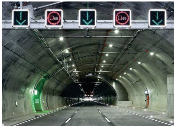
Abbildung 5-5: über der Fahrbahn angeordnete Wechsel- und Dauerlichtzeichen [12]
