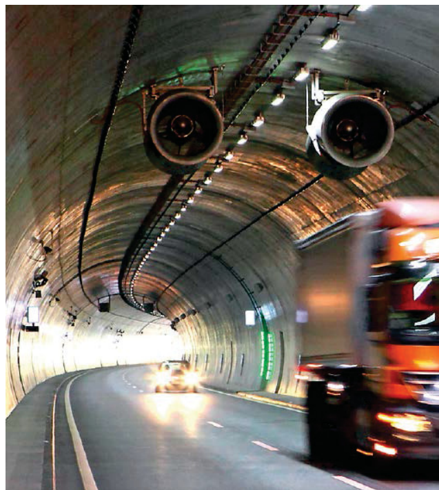
Abbildung 5-2: Längslüftung mit Strahlventilatoren [12]
