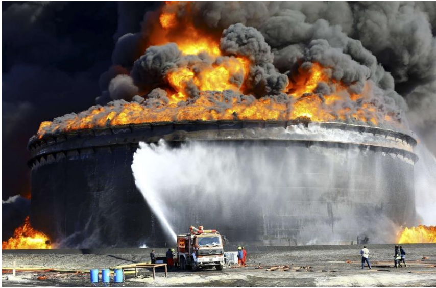
Abbildung 22: Löscharbeiten der Feuerwehr bei einem Öl-Tankbrand [53]
