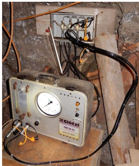
Abbildung 39: Spannungsmessung mittels Handmesspumpe (Glötzl)
