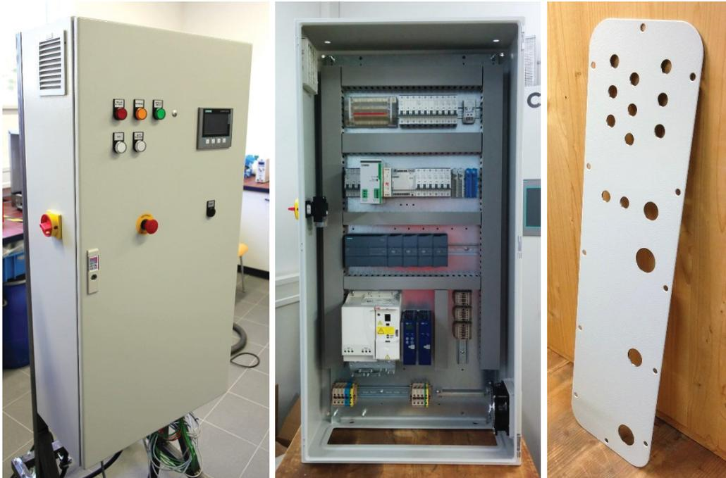
Abbildung 12: Schaltschrank – Aufbau
