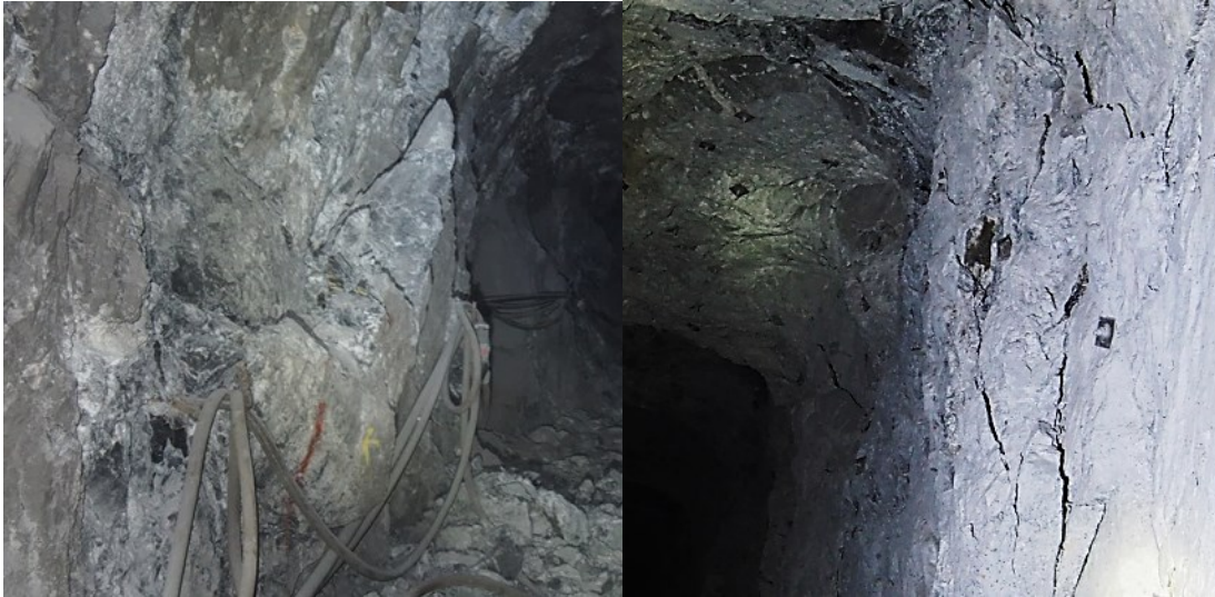
Abbildung 134: Schalenbildung im Bergbau Breitenau
