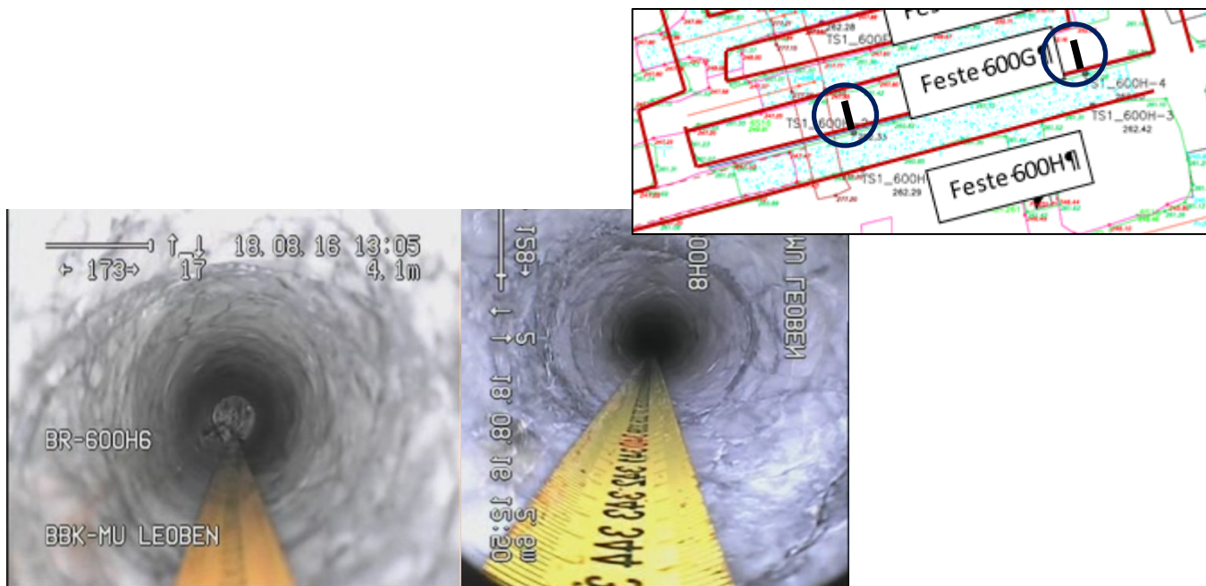
Abbildung 58: Bohrlochkameraaufnahmen 600G (links – Bohrloch H6 bei 4,5m von der Strecke 600H ausgehend, rechts – Bohrloch H9 bei 2,6m von der Strecke 600H ausgehend)
