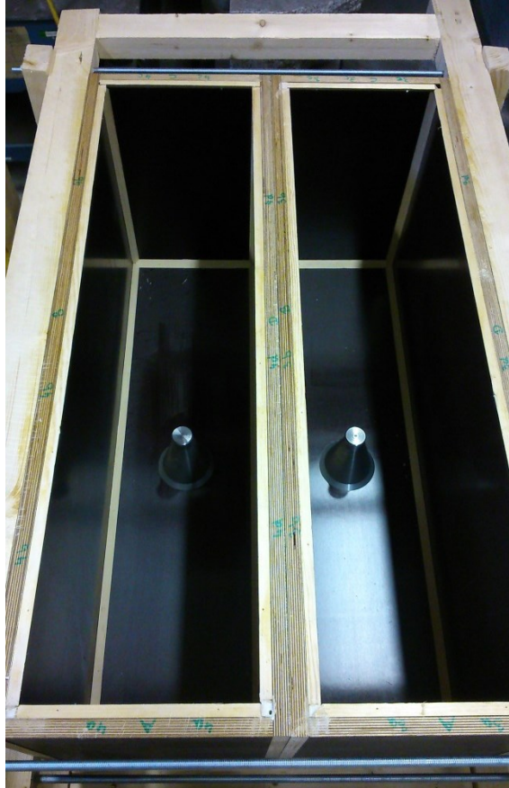
Abbildung 13: Ansicht in die Schalung- Negativform des Dübels
