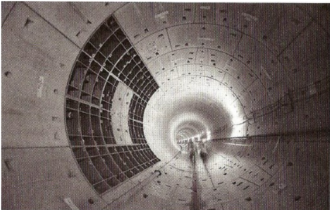
Abbildung 9: Stahltübbingrahmen um eine Querschlagsöffnung [11]
