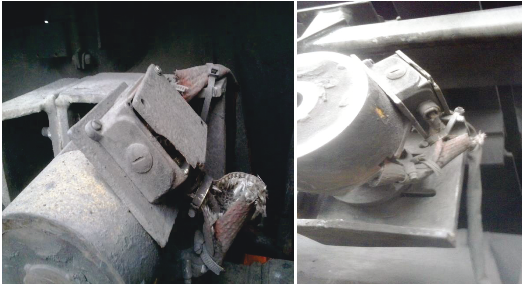
Abbildung 57: Dokumentation des Anlagenzustandes im Bereich Deckelabhebevorrichtung der Füllmaschinen (Stand 03/2014)
