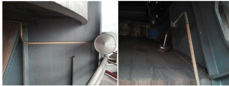
Abbildung 34: Ringleitung zur Gichtbedampfung
