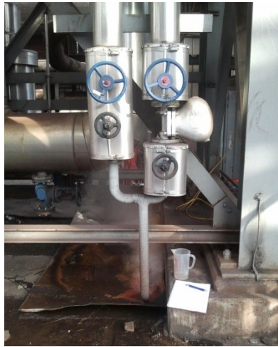
Abbildung 18: Schwimmer-Kondensatabscheider
