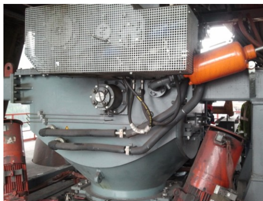
Abbildung 37: Gichtverschluss
