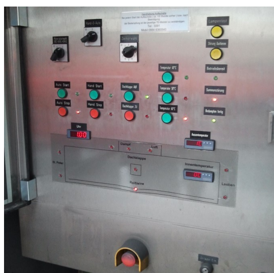
Abbildung 29: Regelarmaturen Auftauhalle
