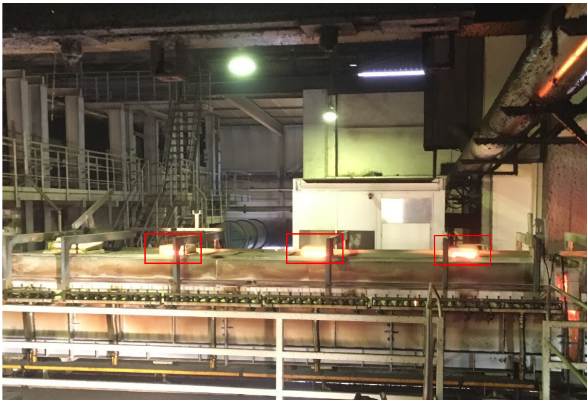
Abbildung 3-16: Arbeitswanne zwischen Feeder 22 und Feeder 23
