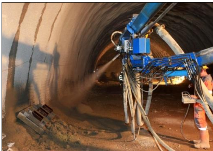
Abbildung 8 Spritzvorgang an der Tunnelbaustelle Zentrum am Berg.
