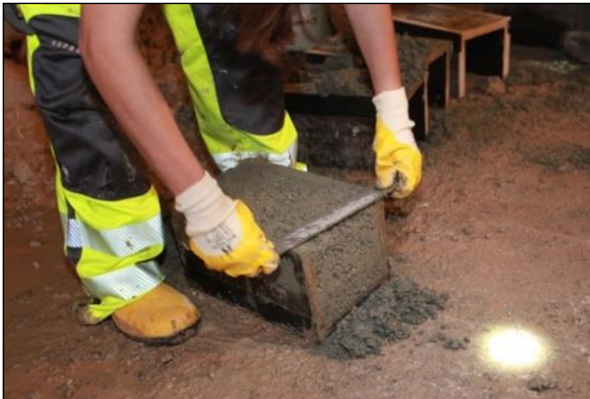
Abbildung 10 Abziehen von überschüssigem Spritzbeton mit Hilfe eines Abziehlineals.
