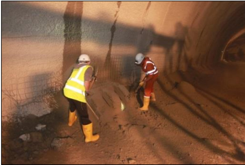
Abbildung 9 Entnahme der Proben aus der Probenvorrichtung mit Hilfe von Spitzhacken.
