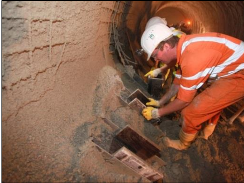
Abbildung 7 Einsetzen der U-Profilschalungen in die Probenhaltevorrichtung an der Ulme.
