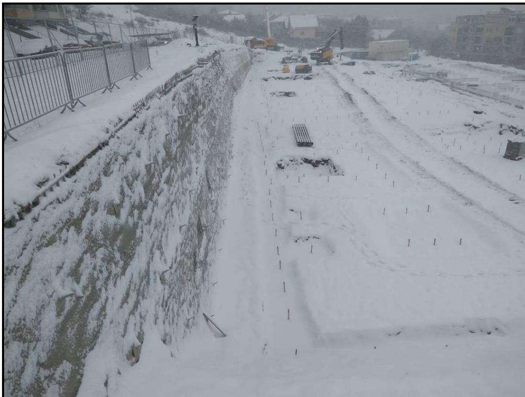
Abbildung 67: Endbauzustand der Spritzbetonnagelwand am 09.01.2019
