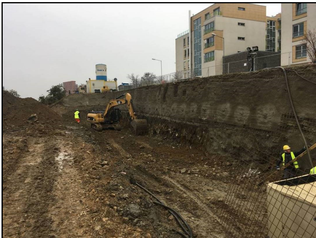
Abbildung 62: Vierter Aushubschritt am 26.11.2018 (Foto: Keller Grundbau Slowakei)
