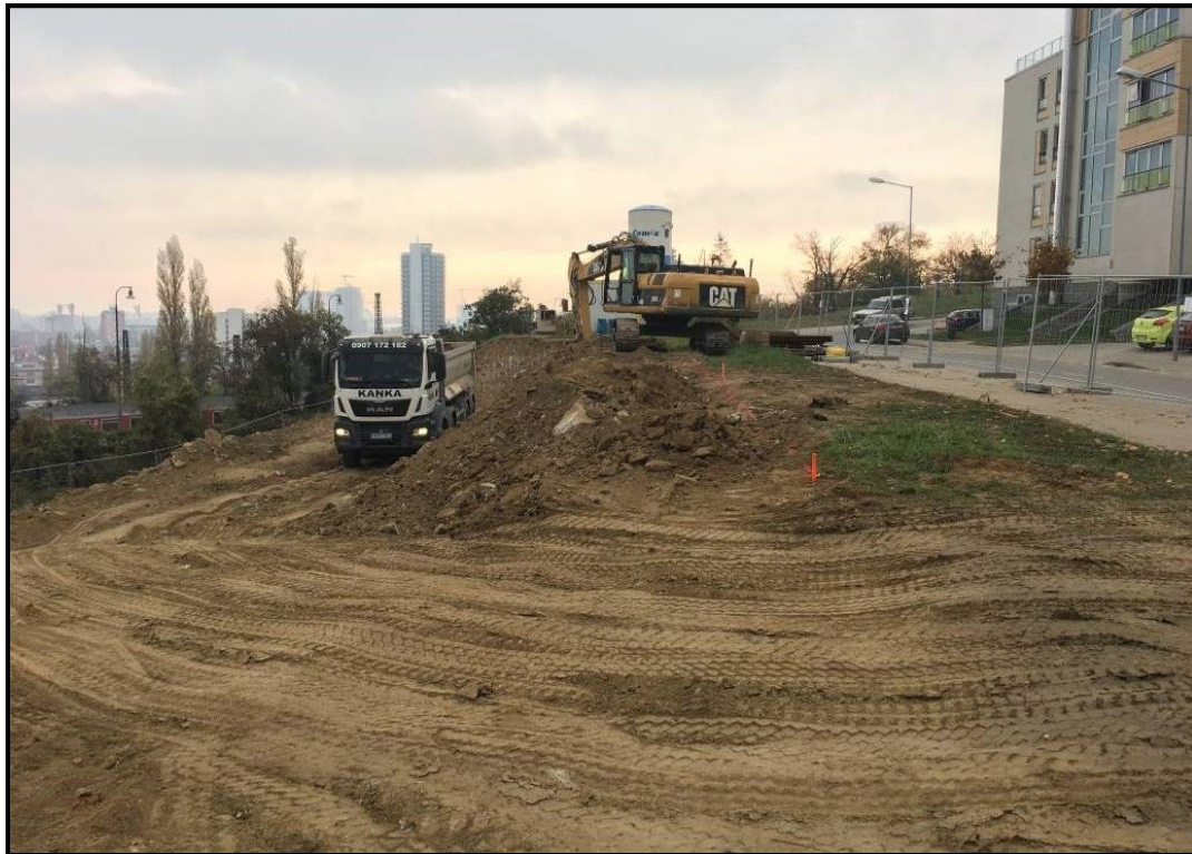
Abbildung 55: Aushubbeginn am 12.11.2018 – südlicher Abschnitt (Foto Keller Grundbau Slowakei)
