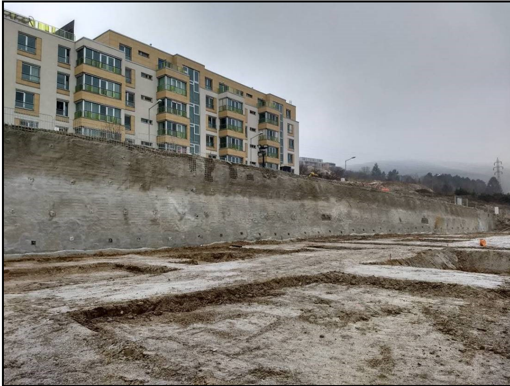
Abbildung 66: Endbauzustand der Spritzbetonnagelwand am 20.12.2018 (Foto: Keller Grundbau Slowakei)
