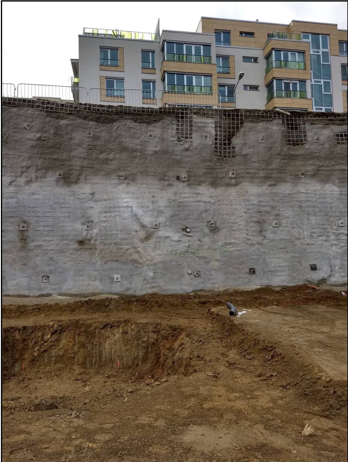
Abbildung 65: Messquerschnitt der Spritzbetonnagelwand im Endzustand am 18.12.2018 (Foto: Keller Grundbau)
