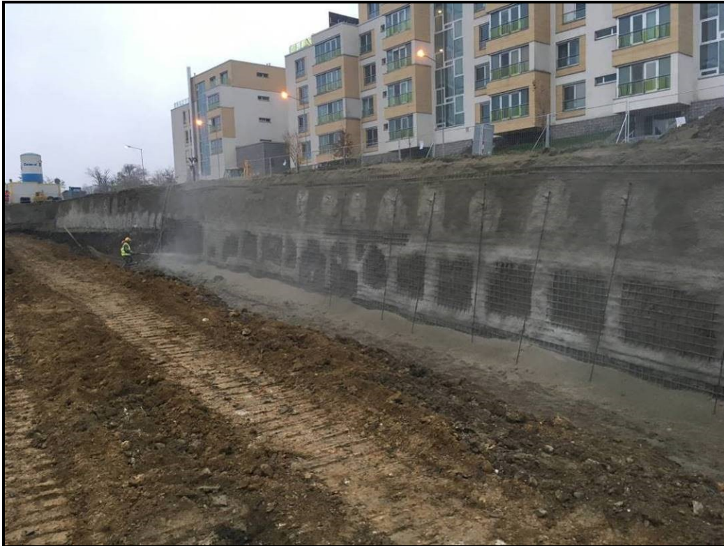
Abbildung 61: Spritzbetonarbeiten nach dem dritten Aushubschritt am 23.11.2018 (Foto: Keller Grundbau Slowakei)
