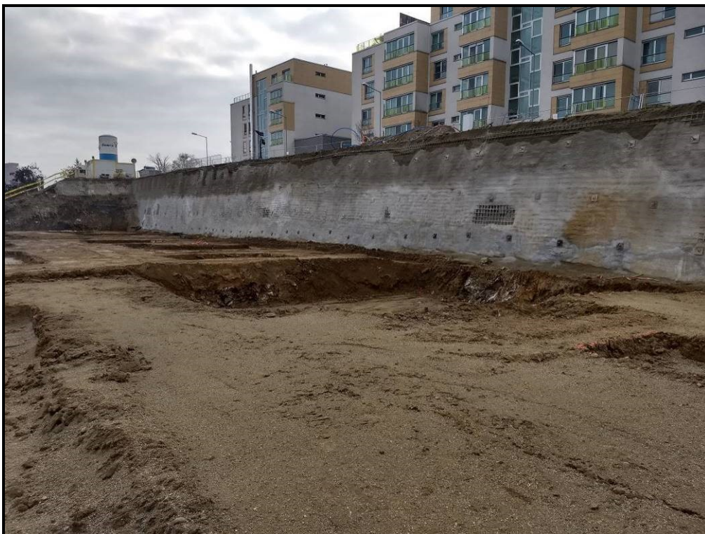
Abbildung 64: Endbauzustand der Spritzbetonnagelwand am 18.12.2018 (Foto: Keller Grundbau Slowakei)
