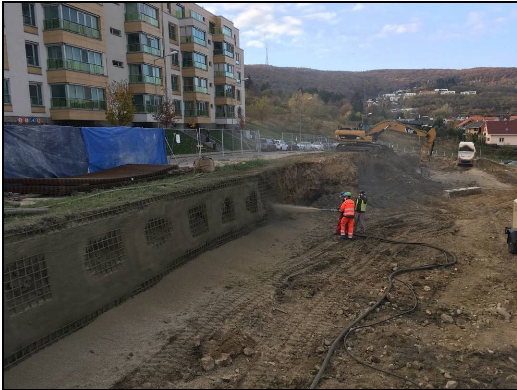
Abbildung 57: Spritzbetonarbeiten nach dem ersten Aushubschritt am 12.11.2018 (Foto: Keller Grundbau Slowakei)
