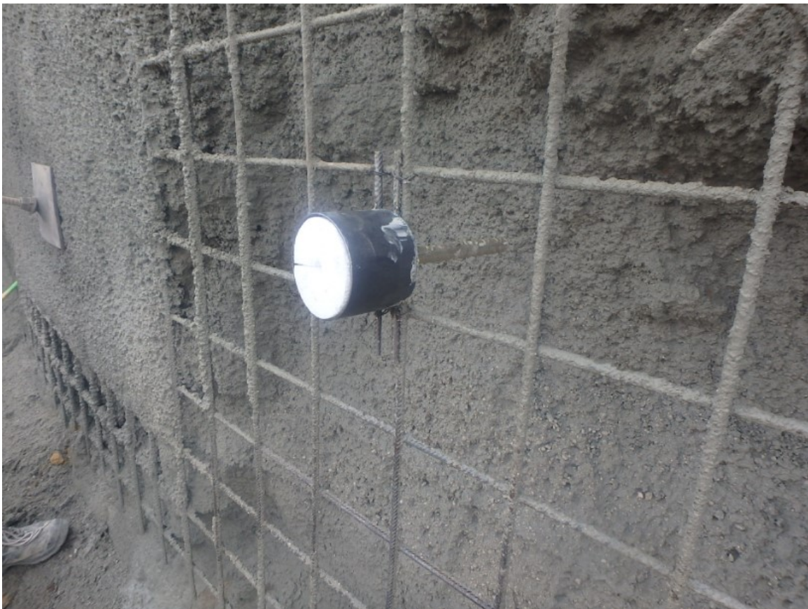
Abbildung 42 Messbolzen an Bewehrungsgitter
