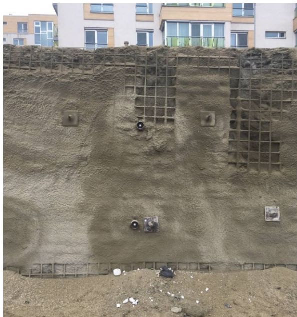
Abbildung 45: Messbolzen nach zwei Aushubschritten (Foto: Keller Grundbau Slowakei)
