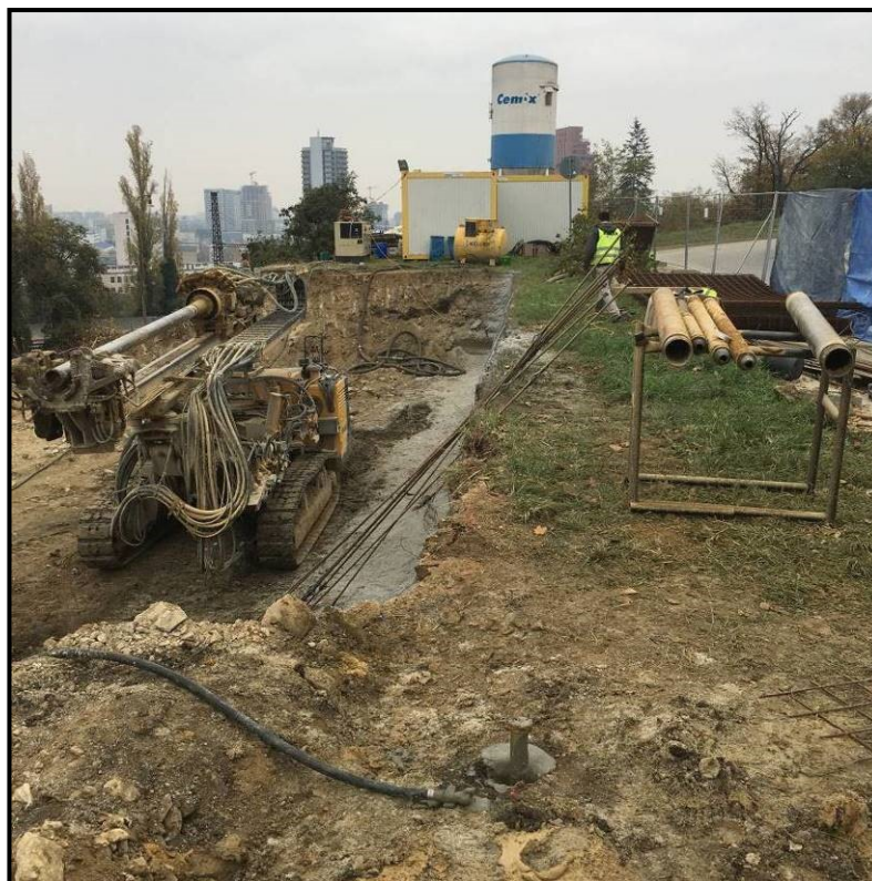
Abbildung 58: Beginn der Bohrarbeiten für die Nägel am 13.11.2018 (Foto: Keller Grundbau Slowakei)
