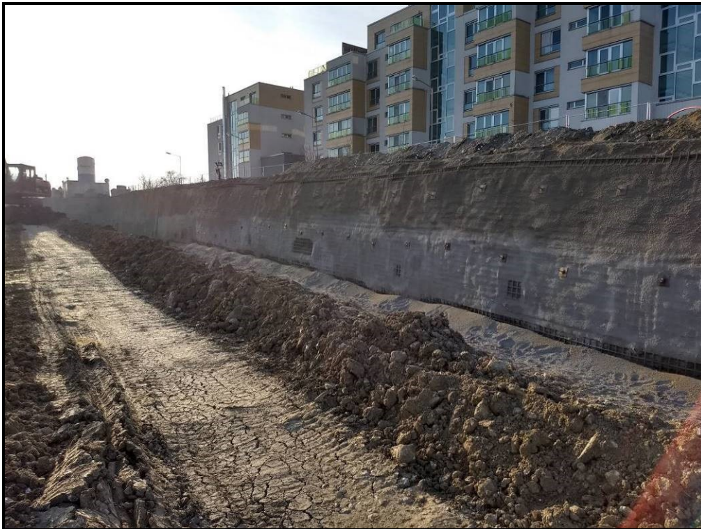
Abbildung 63: Fertigstellung vierter Spritzbetonversiegelung am 28.11.2018 (Foto: Keller Grundbau Slowakei)
