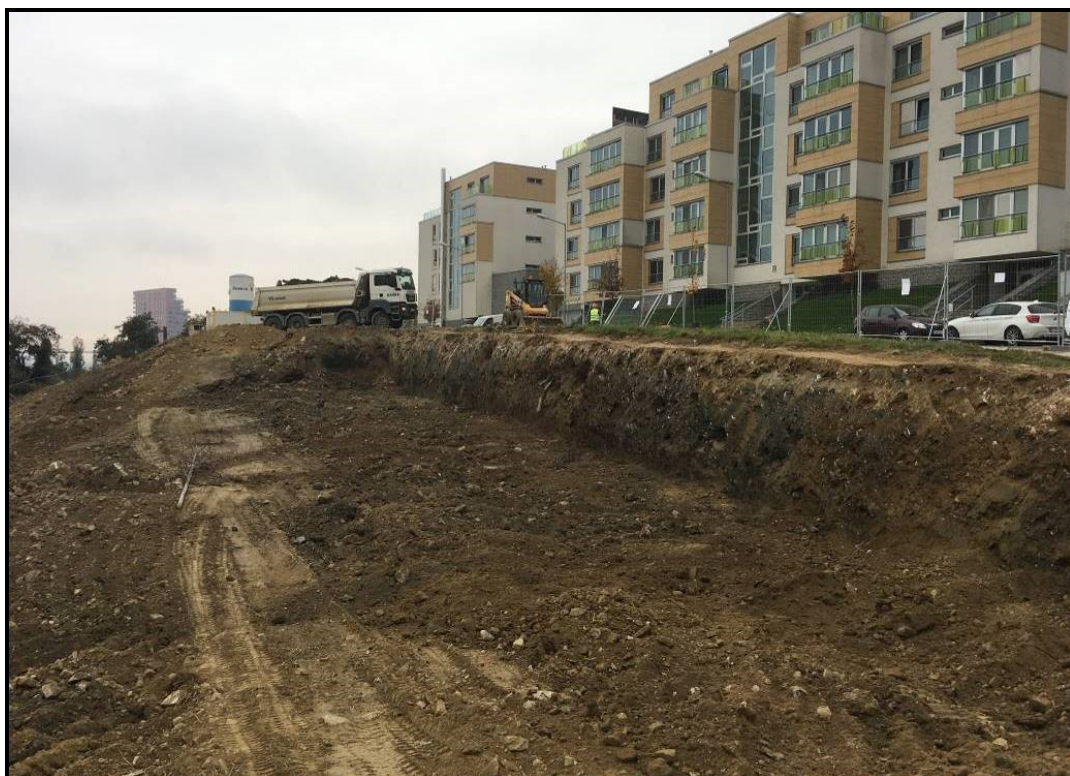
Abbildung 56: Aushubbeginn am 12.11.2018 – nördlicher Abschnitt (Foto Keller Grundbau Slowakei)
