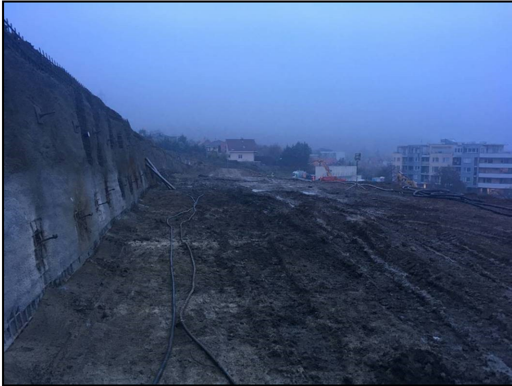
Abbildung 59: Zweiter Aushubschritt fertig gestellt am 21.11.2018 (Foto: Keller Grundbau Slowakei)
