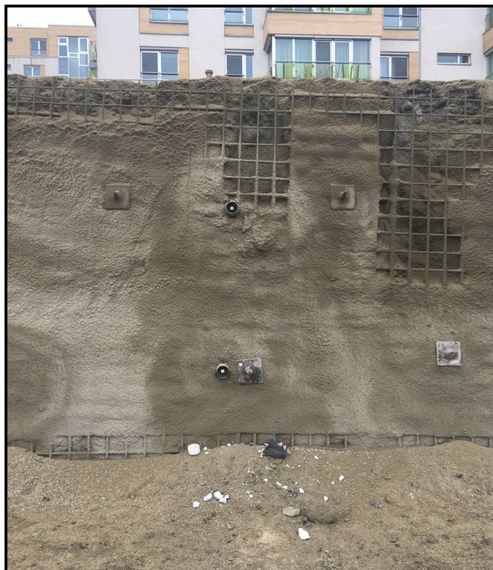
Abbildung 60 Messbolzen nach zwei Aushubschritten am 21.11.2018 (Foto: Keller Grundbau Slowakei)
