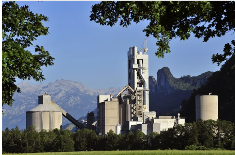
Abb. 8.1: Zementwerk der Firma Leube GmbH in St. Leonhard/Salzburg.
