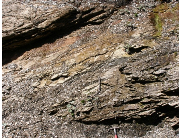
Abbildung 86: Schichtwasseraustritt im Hangenden einer Tonschieferereinschaltung im Metasandstein mit sehr geringer Wasserführung, Aufschlusspunkt 184, siehe Kartenbeilage 1.
