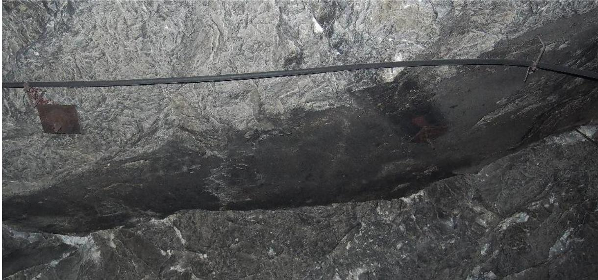
**Abbildung 2: Diskontinuität in einer Strecke des Reviers VI**
