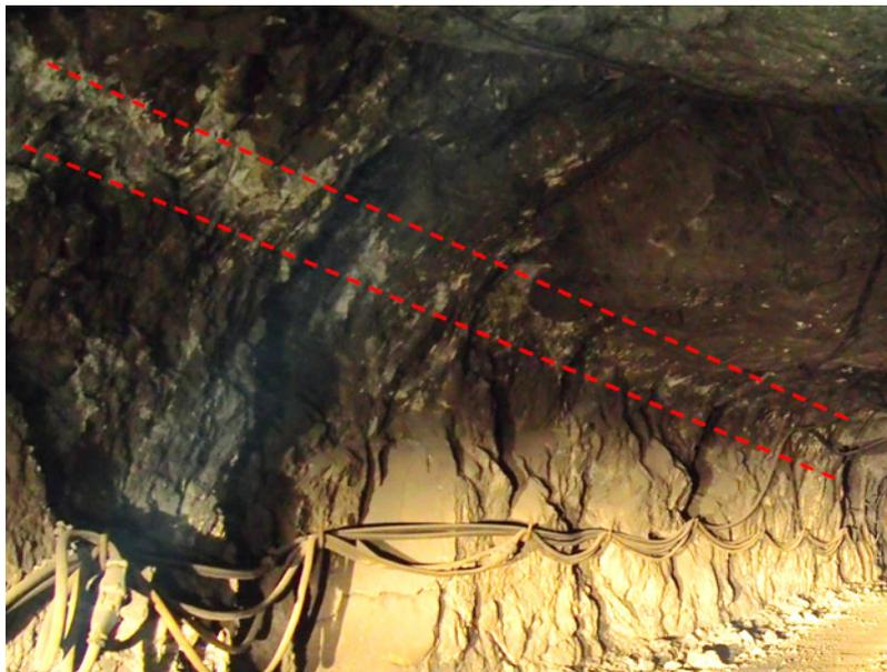
**Abbildung 18: Isolierte Bruchzone an der Grenze von Ulm und Firste**
