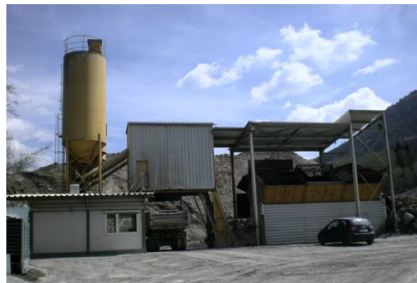
Abbildung 19: Mischanlage Mixolithbeton (PSM)
