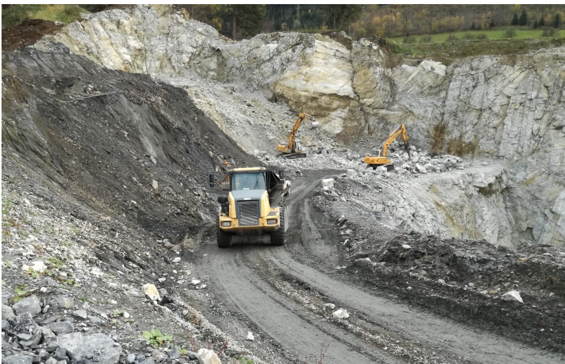
Abbildung 16: Materialförderung mittels LHD-Verfahren
