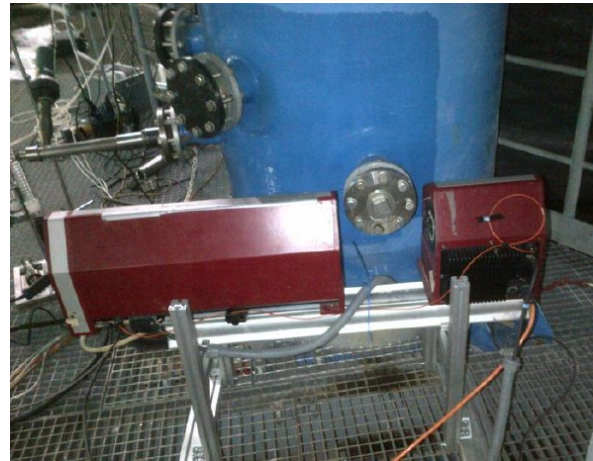
Abbildung 36: Messstelle nach NEF (Reingas)
