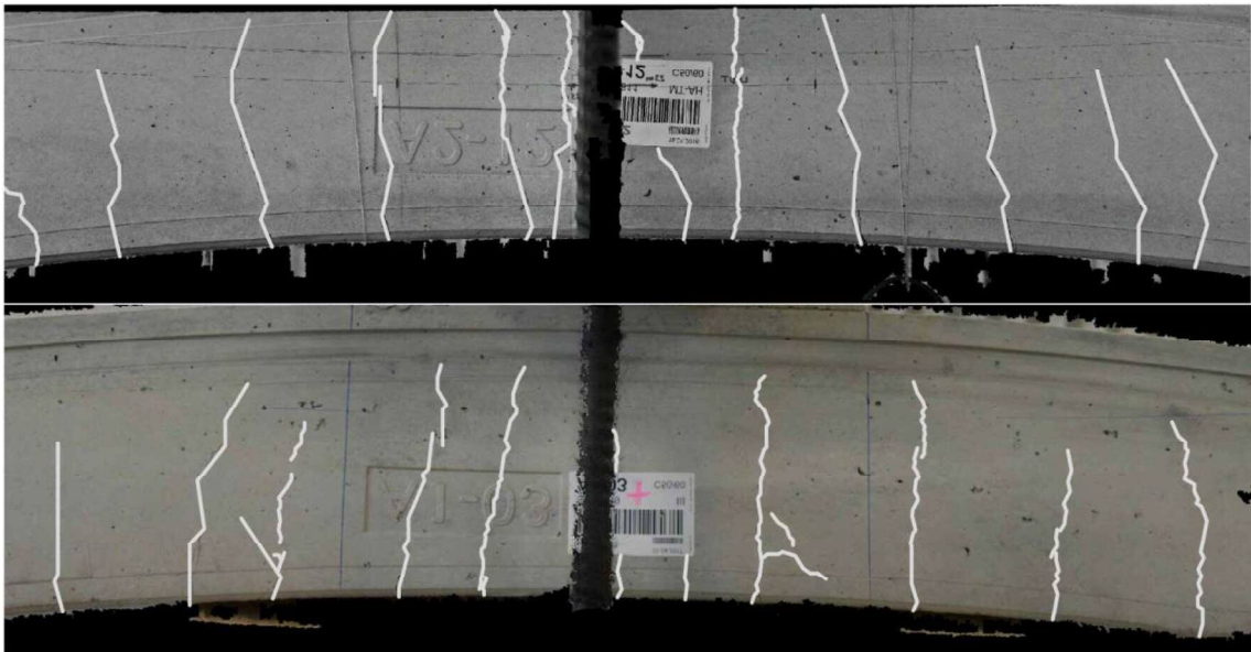
Abbildung 49: Rissbild an der Stirnseite, oben: Versuch 3, unten: Versuch 15
