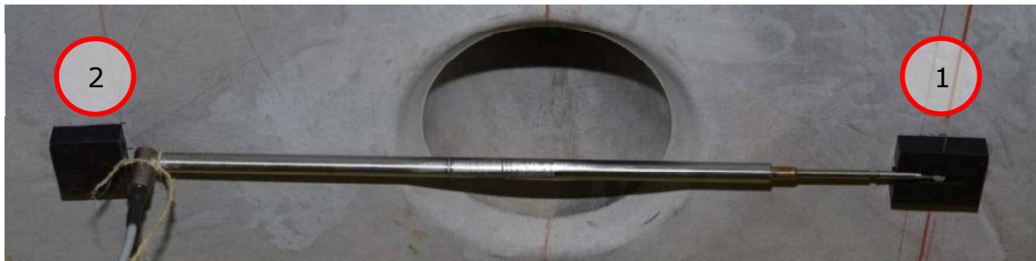
Abbildung 25: Befestigung des LVDT's am Tübbing
