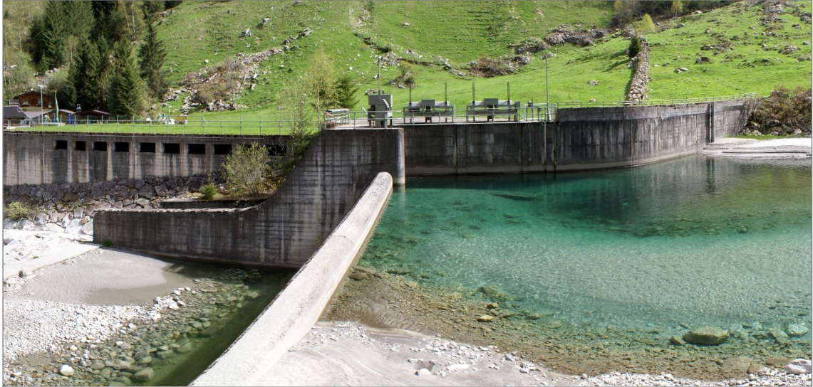
Abbildung 40: Flussfassung Floitenbach der Verbund Hydro GmbH
