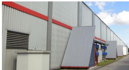
Abbildung 25: Außenansicht der Rottehalle mit Belüftungshäuschen und Ansauggittern
