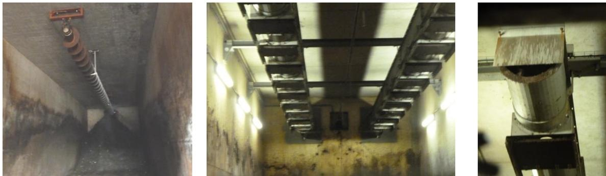
Abbildung 28: Fotos einer Rottebox mittels Beschickung durch eine freie Schnecke (links) bzw. durch eine eingehauste Schnecke mit Falltüren (Mitte bzw. rechts)
