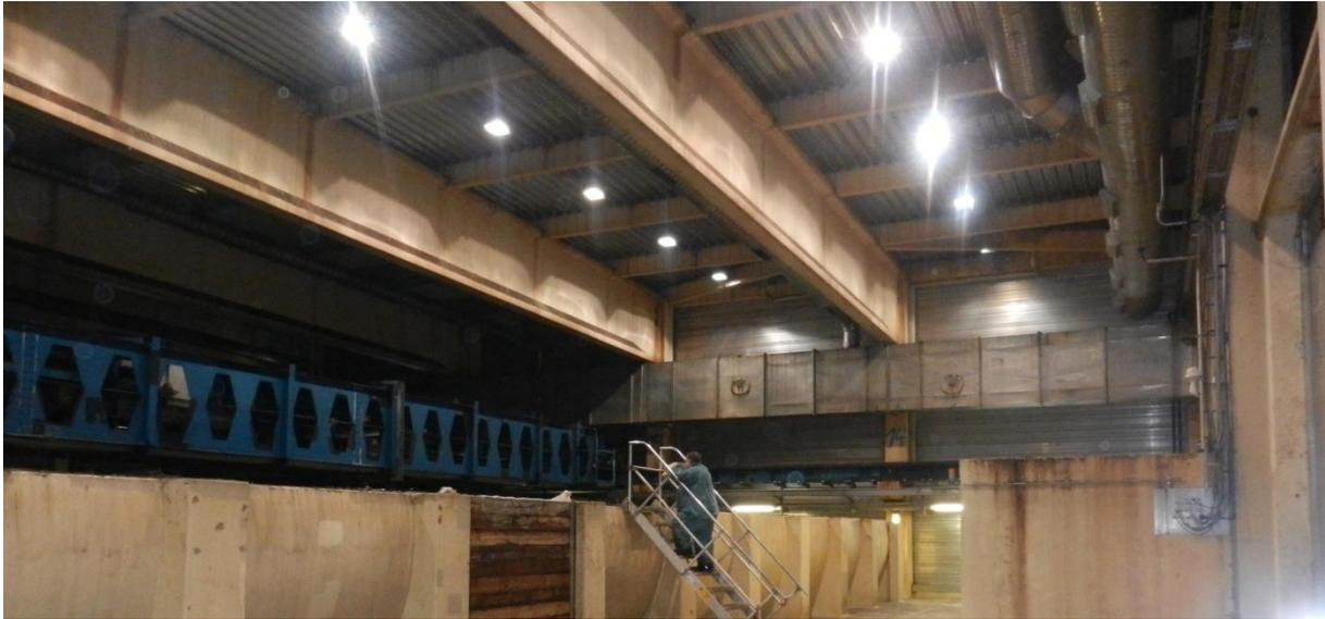
Abbildung 24: Blick auf die Einblas- und Absaugrohrleitungen in der Rottehalle
