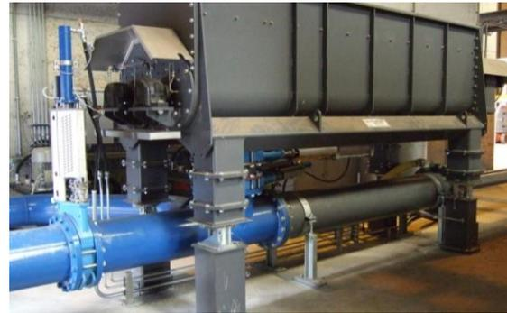
Abbildung 17: Mischer samt Plattenschieber [23]
