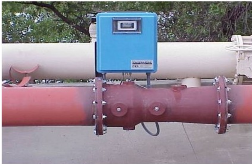
Figure 42 On-line venturi meter 4°
