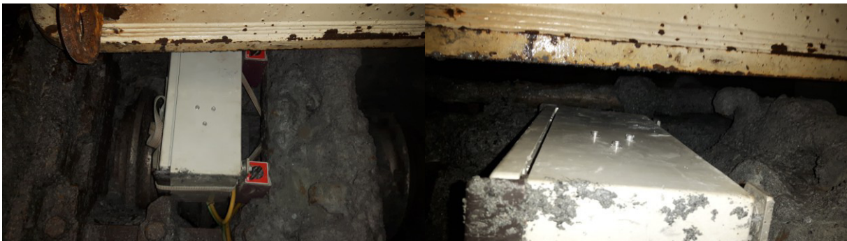
Abbildung 23: Geringe Platzverhältnisse zwischen feststehendem Bohrkopf und drehendem Schneidrad
