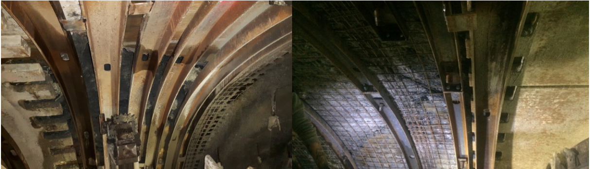
Abbildung 21: links: Stützmitteleinbau direkt hinter dem Fingerschild; rechts: Stützmitteleinbau im Fingerschild
