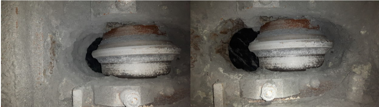
Abbildung 28: links: Diskenkasten mit Material zugesezt; rechts: Diskenkasten nach Entfernung des Materials
