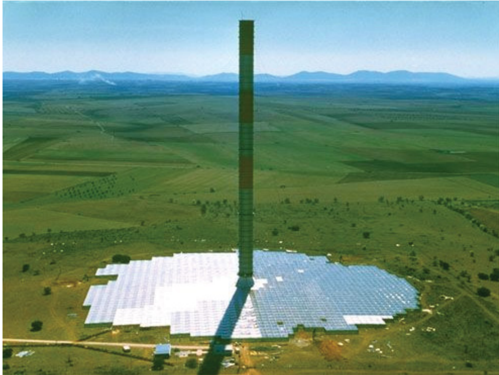
Abb. 2.7: Aufwind-Experimentalkraftwerk in Manzanares, Spanien
