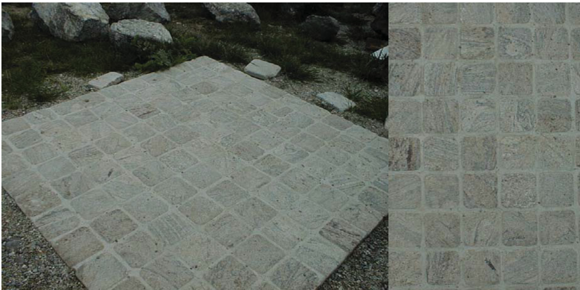
Abbildung 39: Verlegung antikisierter quadratischer Platten
