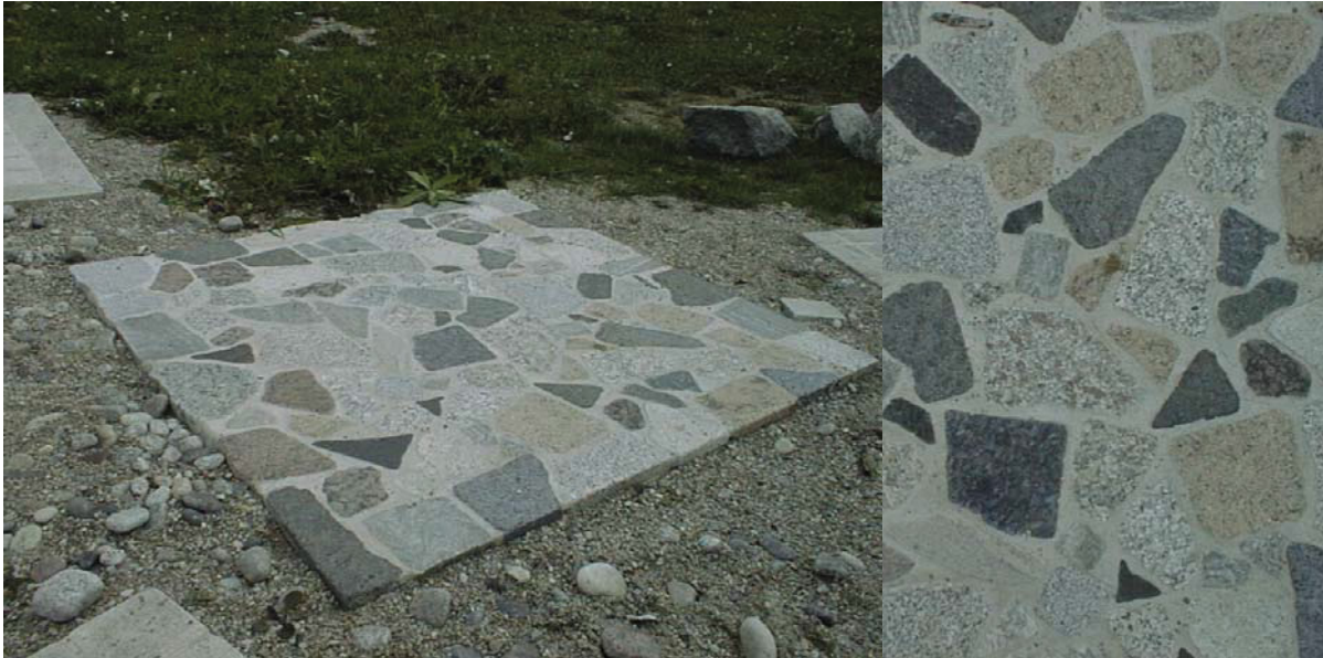
Abbildung 40: Verlegung antikisierter Polygonplatten
