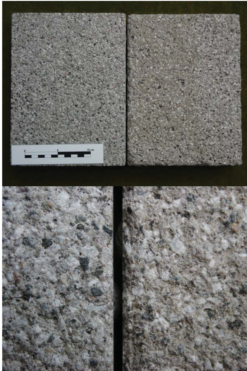
Abbildung 38: Bild oben zeigt den feingestrahltten Betonstein (links) im Vergleich zum gestockten (rechts). Bild unten zeigt davon die Detailansicht
