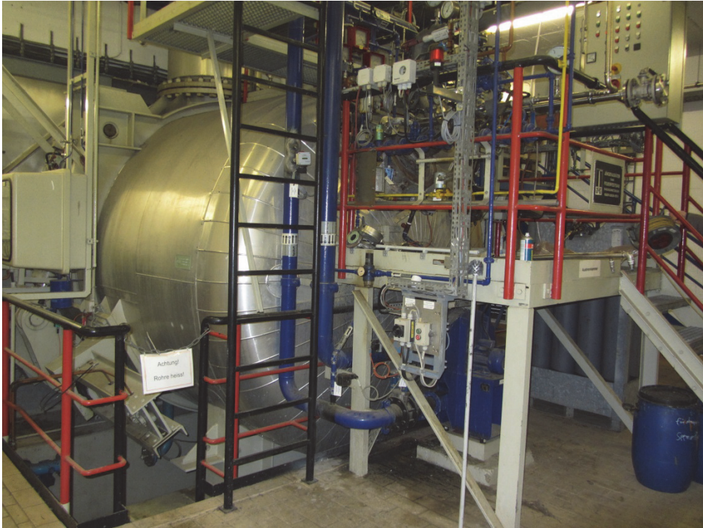
Abbildung 81: Außenansicht der Ausbrennkammer
