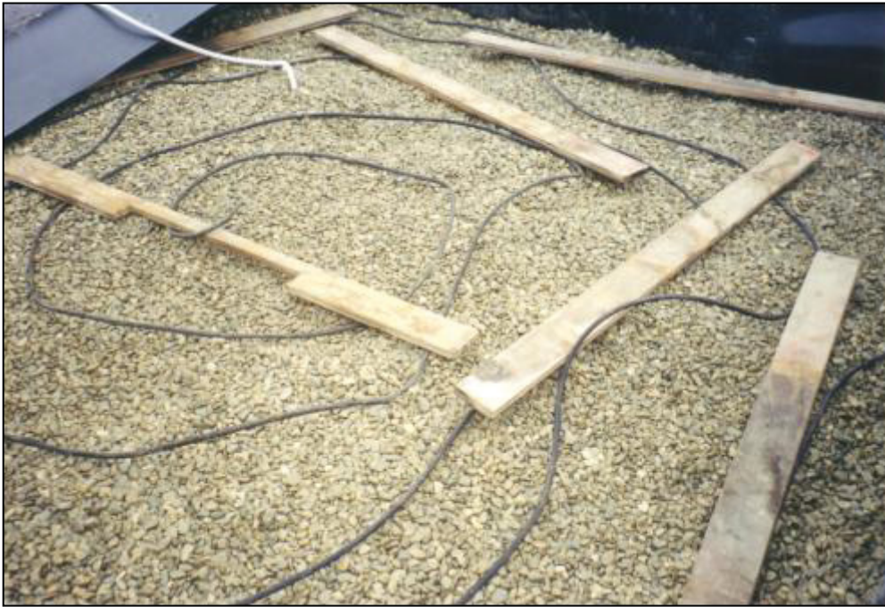
Abbildung 3.5: Schlauchverlegung der Rückbewässerungsleitungen
