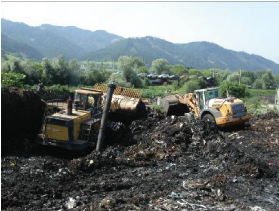
Abbildung 5.5: Entfernen der Überschüttung
