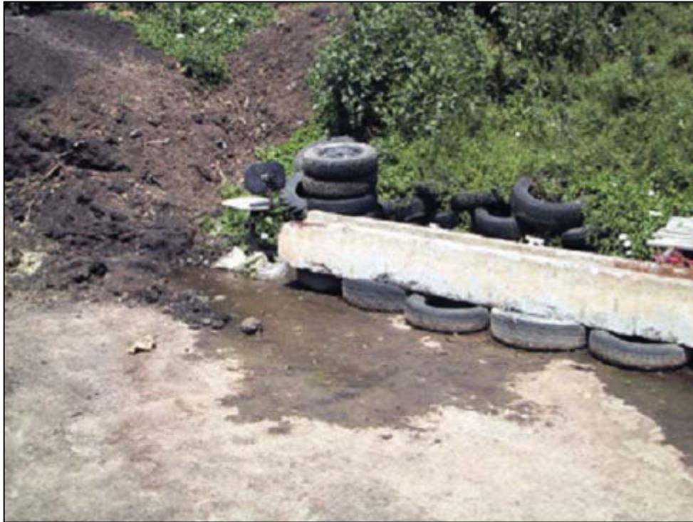
Abbildung 4.16: Vorplatz nach der Bewässerung
