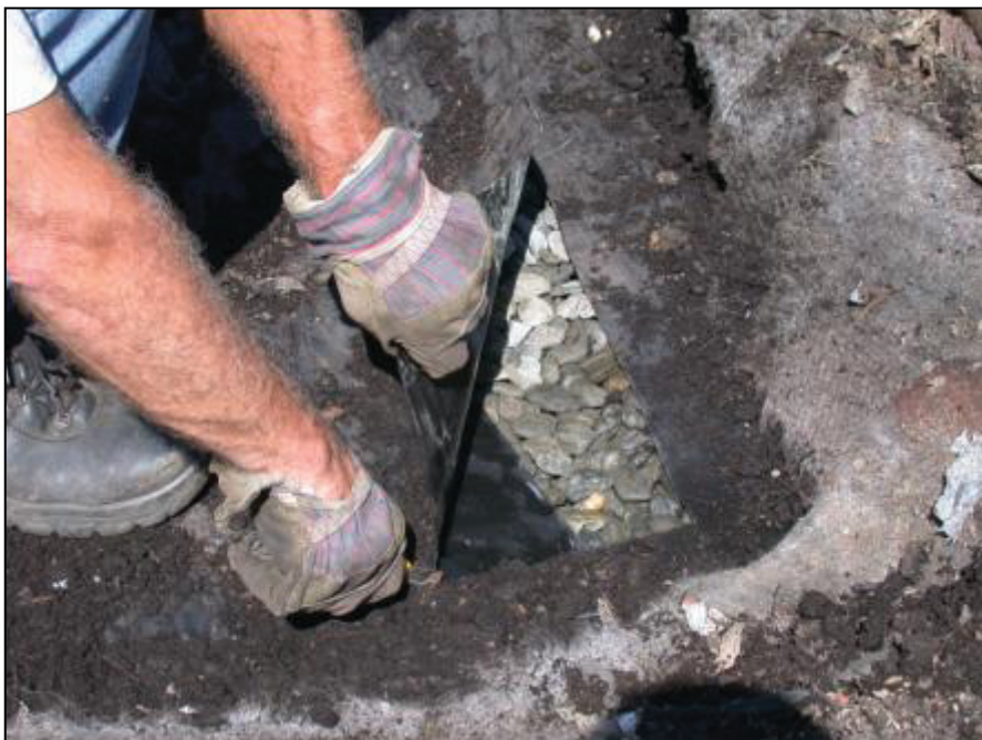
Abbildung 5.12: Entfernen der Abdeckfolie
