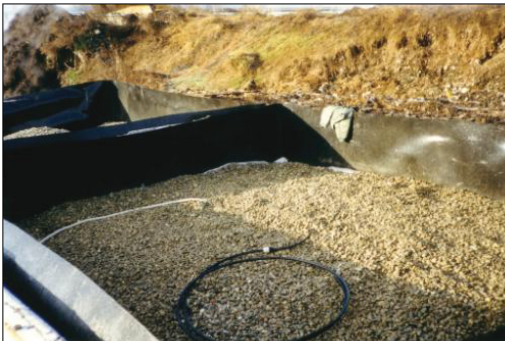
Abbildung 3.4: Gasdrainageschicht
