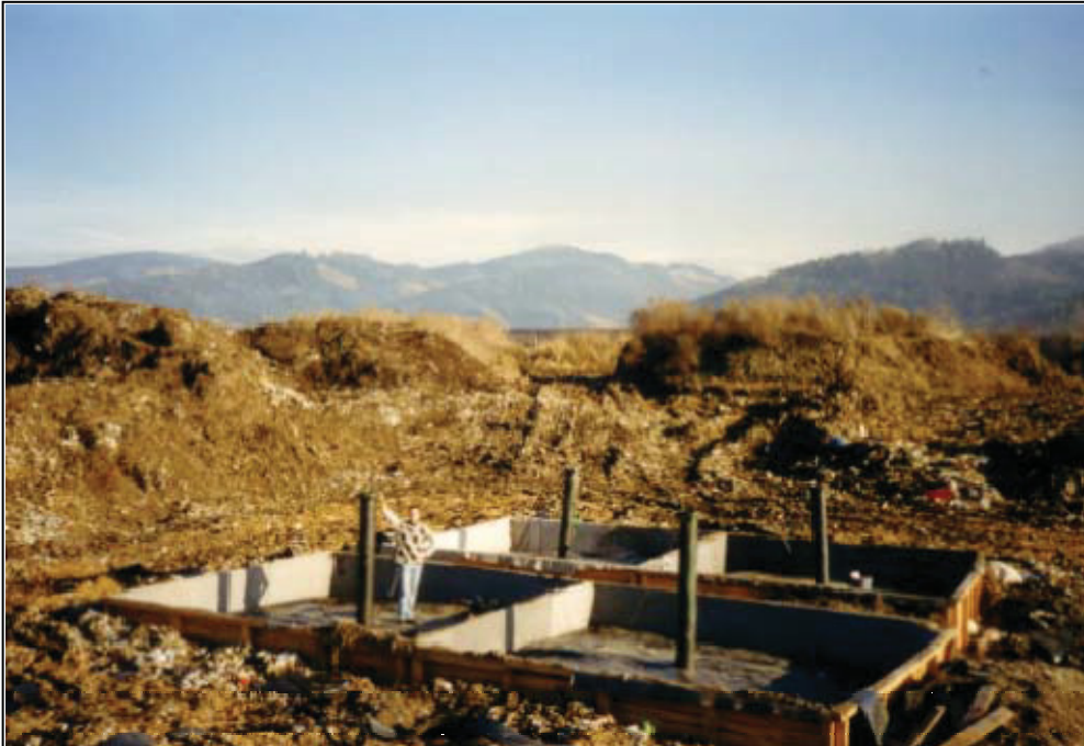
Abbildung 3.8: Fertiggestellte Kompartimente (ohne Überschüttung)
