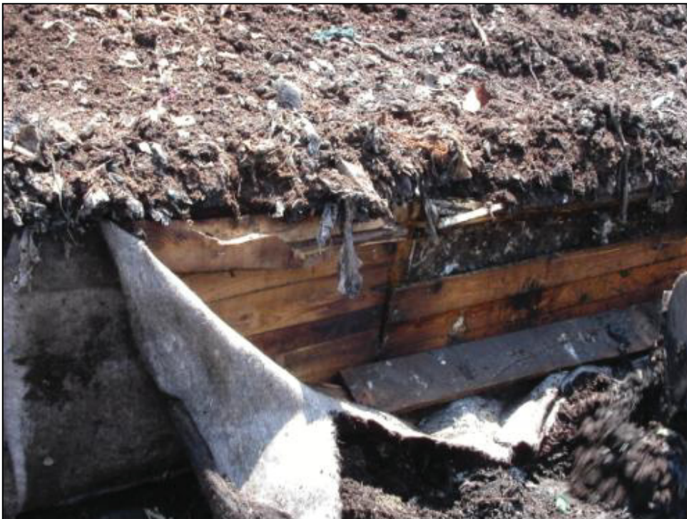
Abbildung 5.9: Stützschalung der Kompartimente
