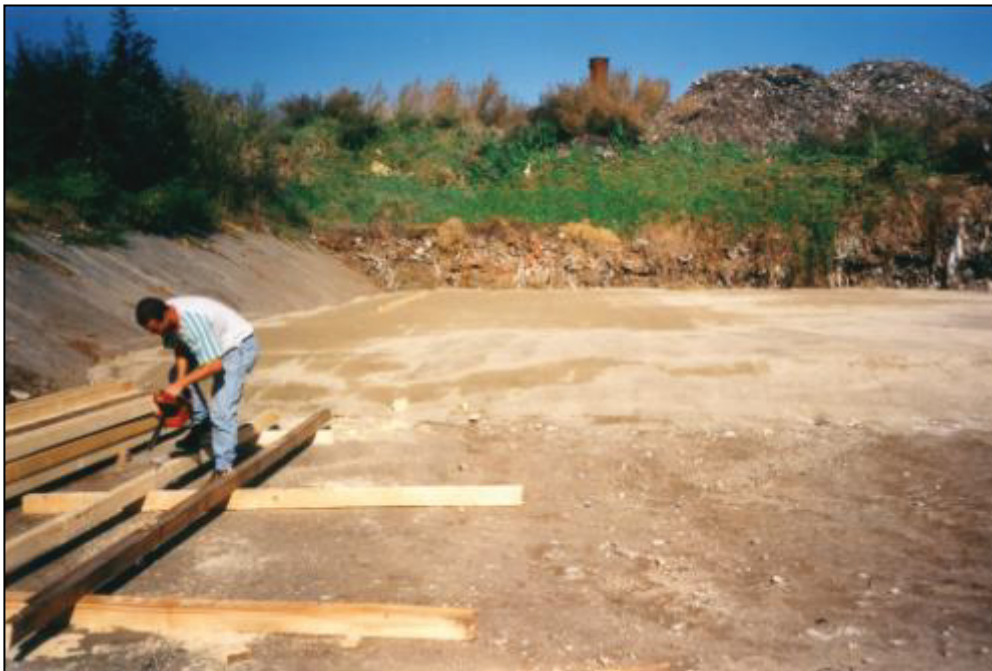
Abbildung 3.1: Beginn der Arbeiten
