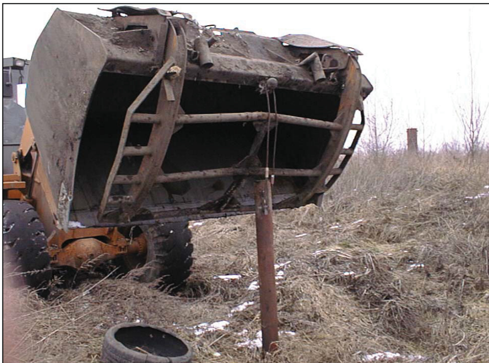
Abbildung 5.3: Ziehen des Rohres mittels Radlader
