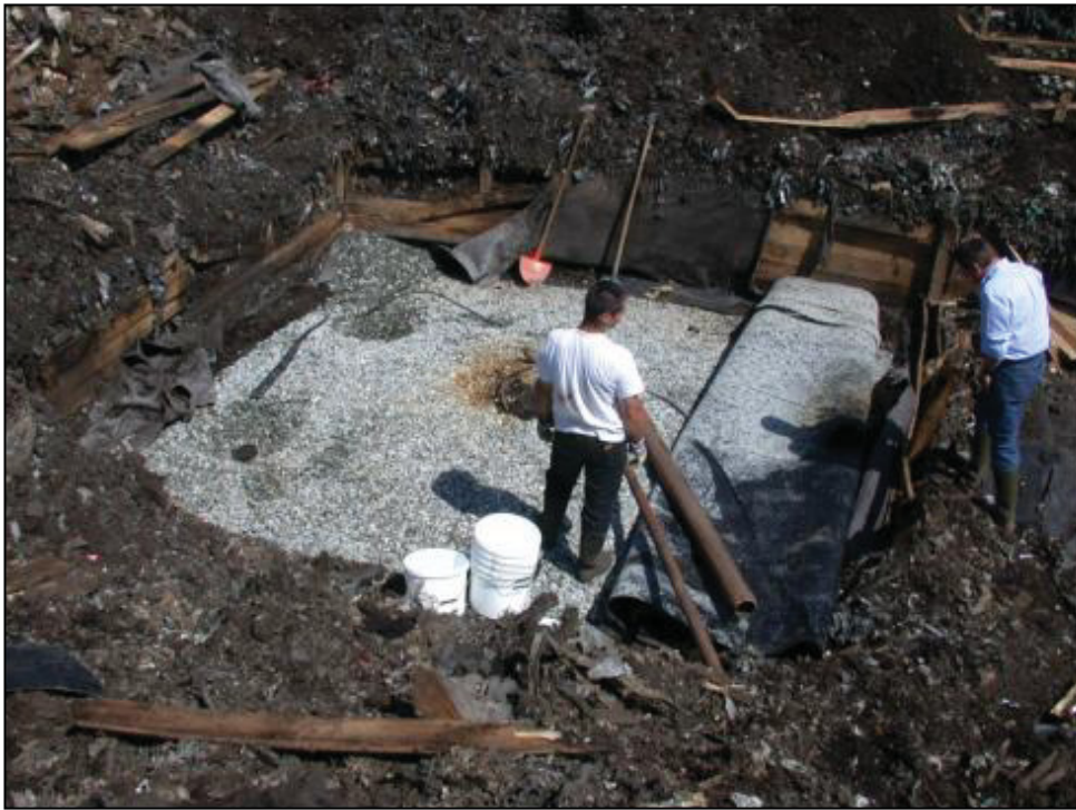
Abbildung 5.13: Vorbereitung für Bohrkernentnahme
