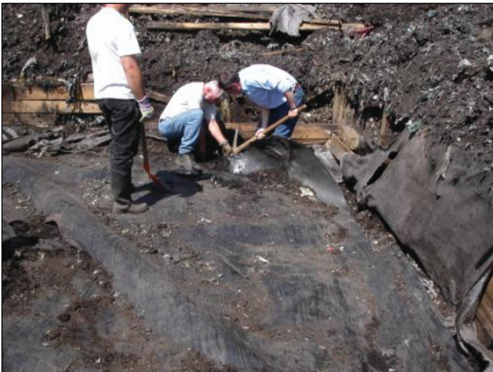
Abbildung 5.10: Entfernung der Abdeckfolie
