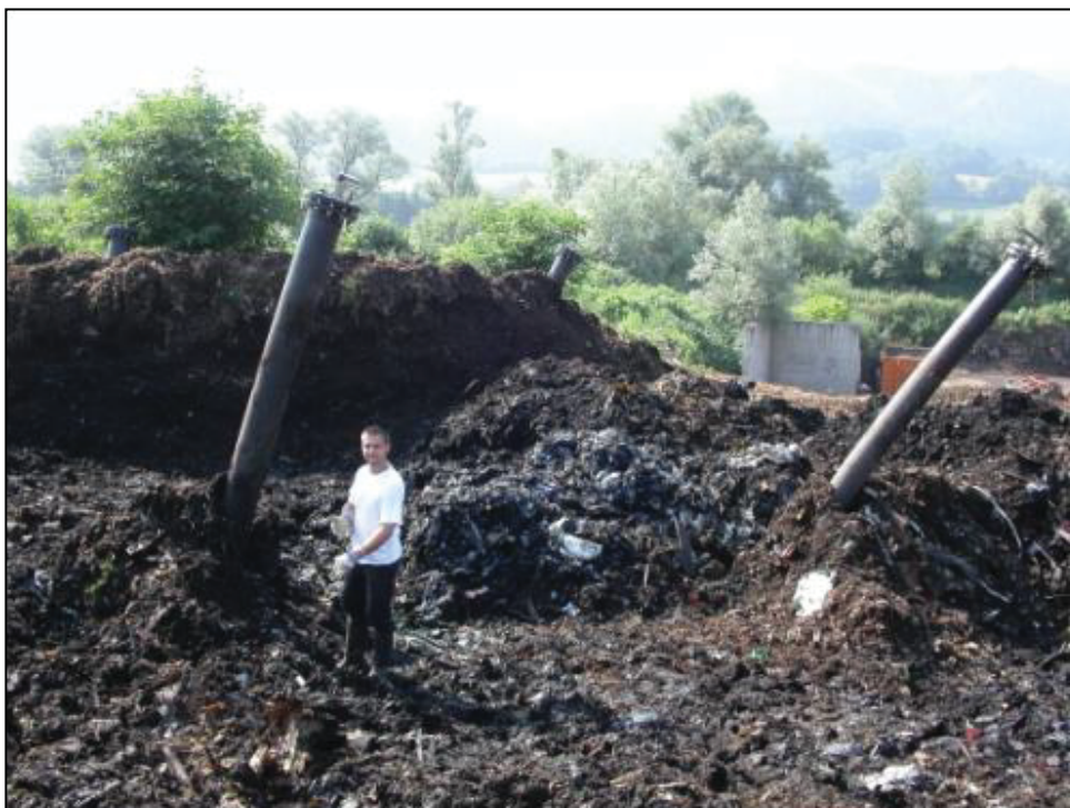
Abbildung 5.6: Entfernung der Überschüttung
