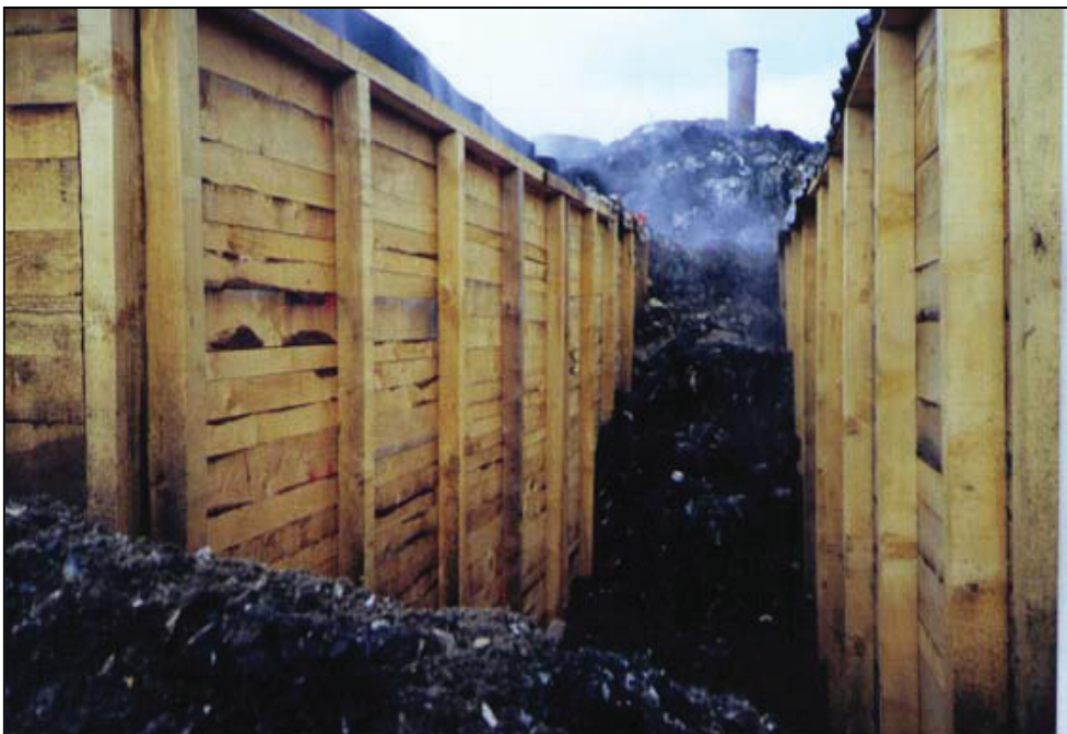
Abbildung 2.6: Verfüllung der Zwischenräume
