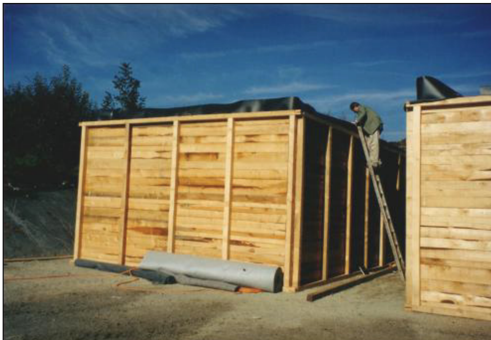
Abbildung 3.2: Errichtung der Stützschalungen
