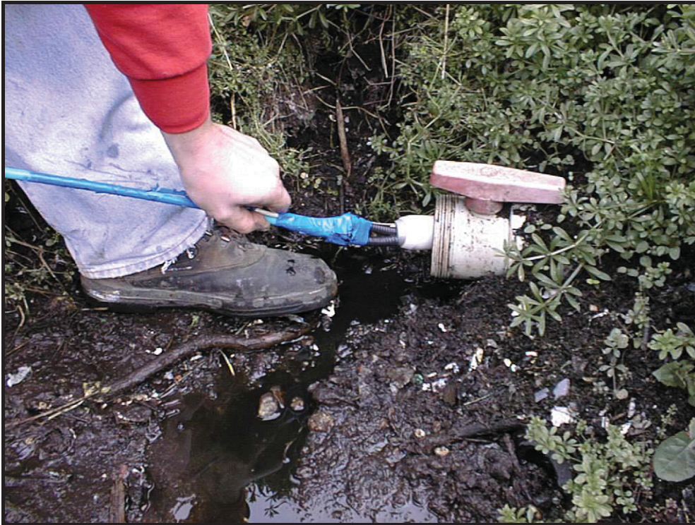
Abbildung 4.20: Einführen der Kanalkamera
