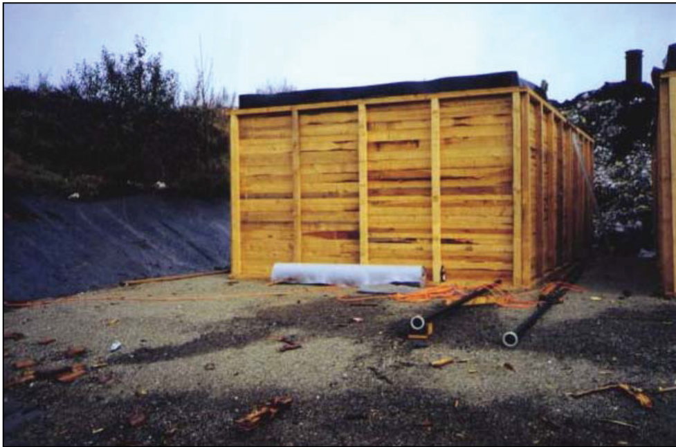
Abbildung 2.5: Kompartiment mit Sickerwasserleitungen
