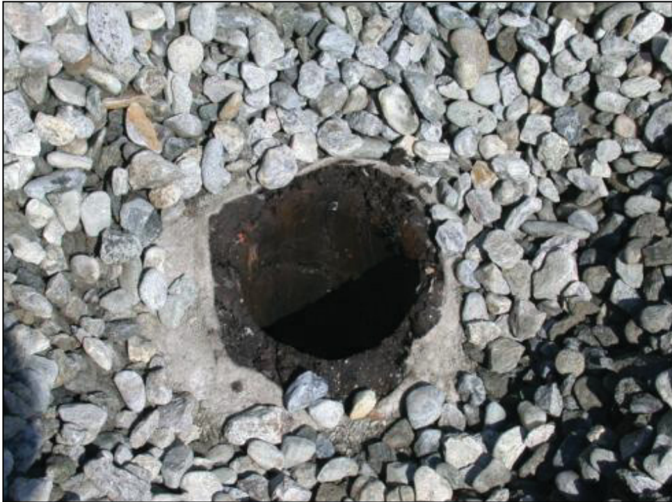
Abbildung 5.15: Verbleibendes Bohrloch der Kernbohrung
