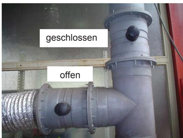
Abbildung 28: Stellung der Klappen nach dem Filter
