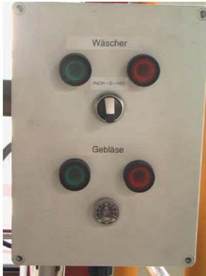
Abbildung 29: Drehzahlregelung für Saugzug
