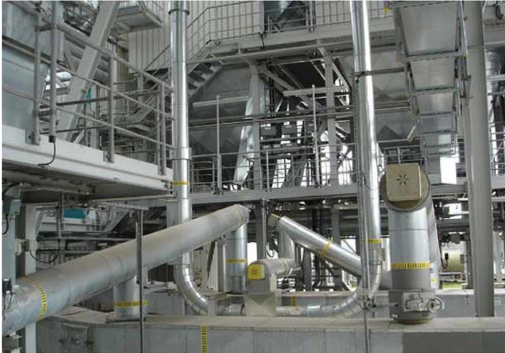
Abbildung 74: Ausführung eines Trogkettenförderer der Firma Schrage zum Abtransport von Reststoffen aus einem Gewebefilter im Rauchgaskanal, Förderleistung 20 m<sup>3</sup>/h
