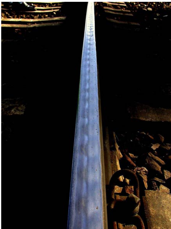
Abbildung 27: Kurzwellige Schienenriffeln
