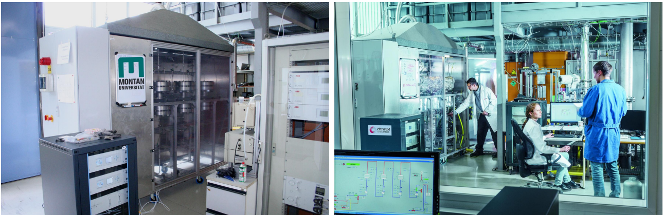
Abbildung 3.17.: Laboranlage zur Methanisierung von CO_2 am Lehrstuhl VTiU, Grundabmessungen: LxBxH = 2,6x1x2 m
