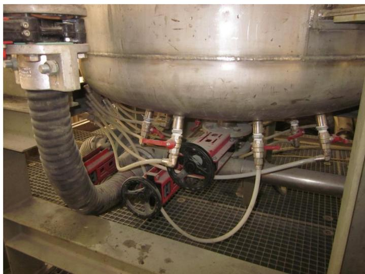
Abbildung 6: Pumpensumpf mit Druckluftanschlüssen
