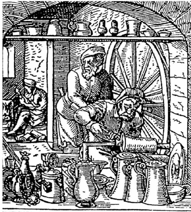
Abb. 2.13: Drückmaschine aus Holz mit manuellem Schwungradantrieb [30]
