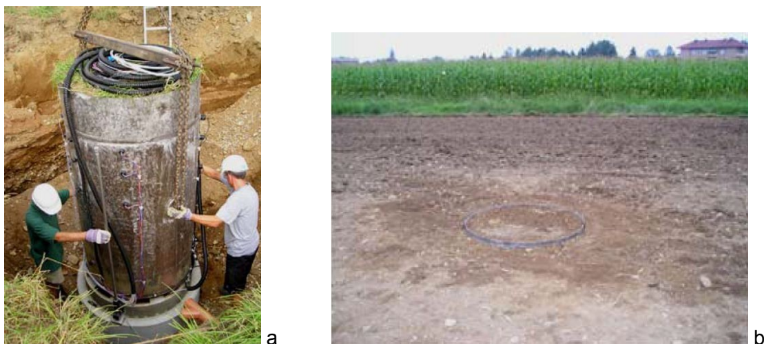
Abbildung 24: a.) Anbringen des Lysimeters auf der Betonunterplatte. Deutlich zu sehen der abnehmbare oberste Ring b.) Fertig eingebautes Lysimeter [36, Seite 47]
