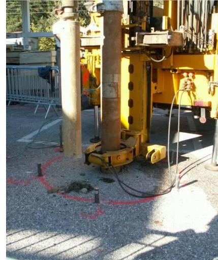
Abbildung 24: links: Gerät zur Einbringung der Anoden; rechts: Bohrgerät für Kathodenkompartiment
