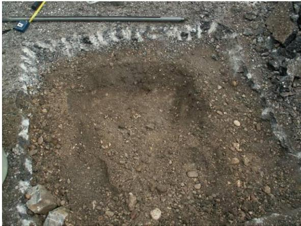
Abbildung 25: Geschütteter Kies und Asphaltdecke
