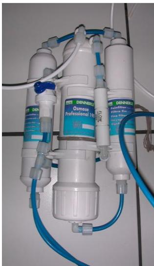
Abbildung 18: Umkehrosmoseanlage
