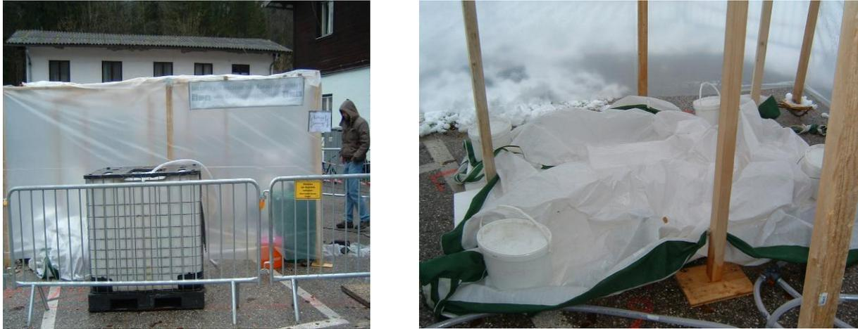
Abbildung 30: links: Umhausung mit 1000 l Sammelbehälter; rechts: Isolierung des Arbeitsplatzes
