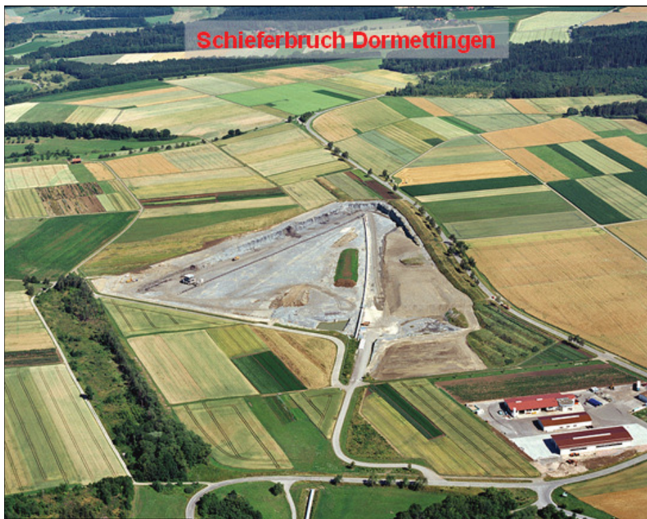
Abbildung 2: Luftaufnahme Schieferbruch Dormettingen
