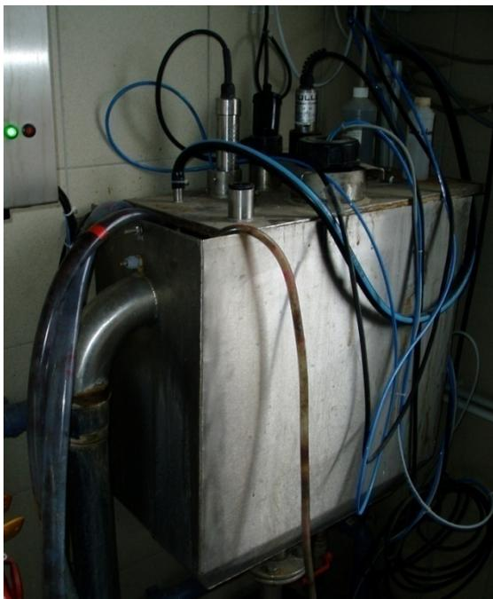
Abbildung 24: Vorlagebehälter Kläranlagenablauf mit RHV-internem Messsystem
