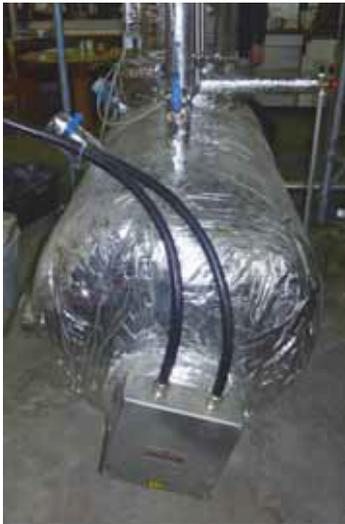
Abbildung 60: Installierter Heizflansch
