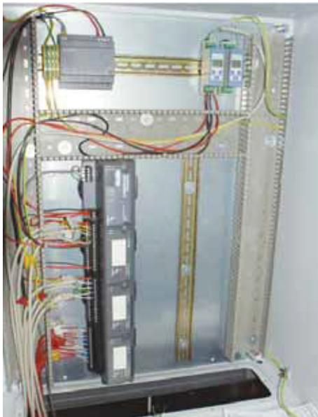
Abbildung 72: Schaltschrank mit National Instruments Modulen
