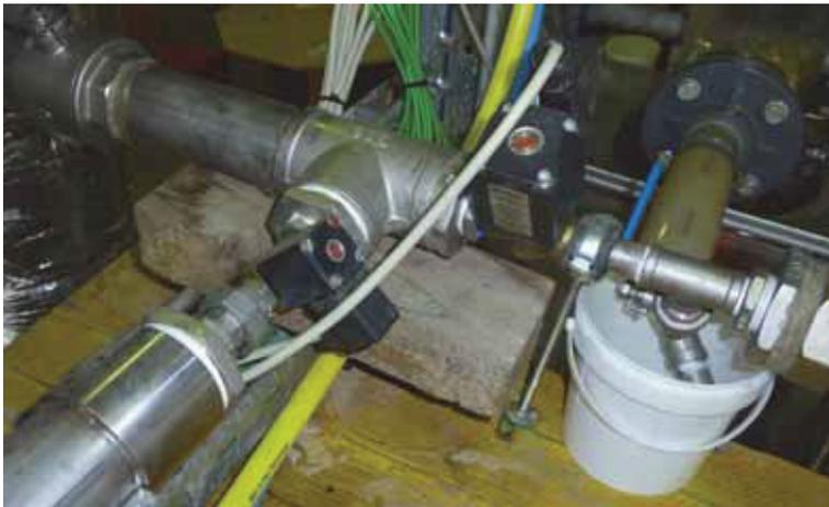
Abbildung 69: Verzweigungsstelle von S7 (links), S8 (links unten) und S9 (rechts)
