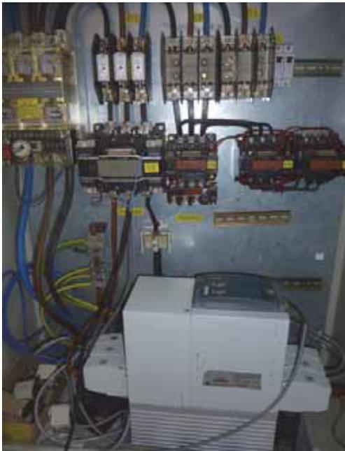
Abbildung 73: Schaltschrank mit Thyristor
