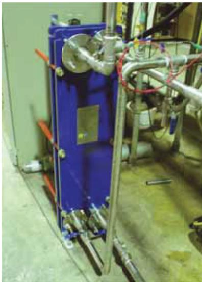
Abbildung 65: Wärmetauscher mit Anschlüssen
