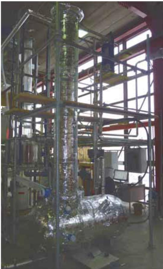
Abbildung 61: Gerüst, Kolonne und Sumpftank
