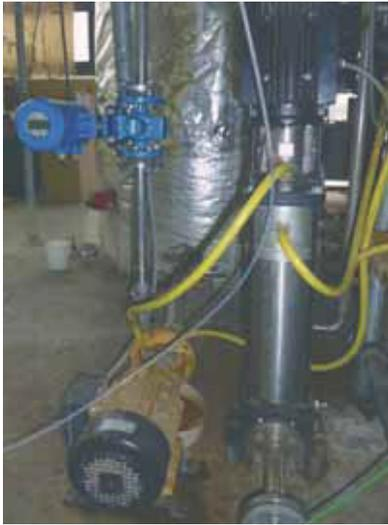
Abbildung 66: Schmitt-Pumpe (links) und Grundfos-Pumpe (rechts)
