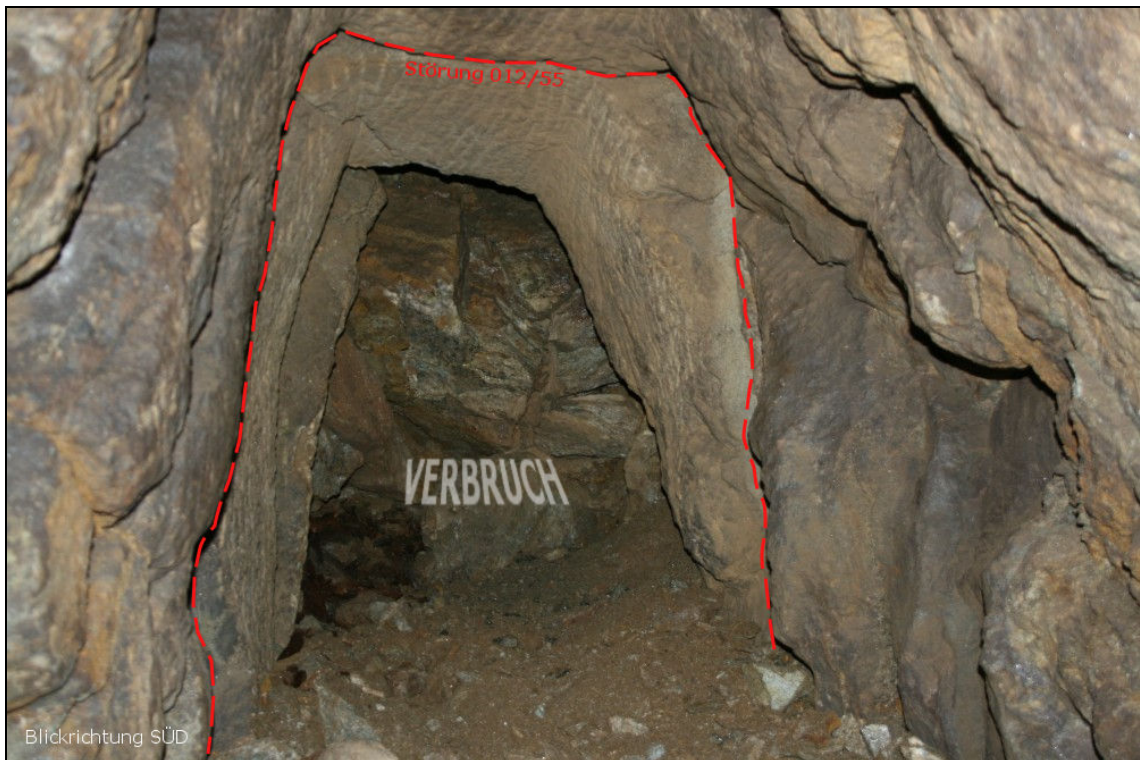
Abb. 14: Verbruch bei LFM 21, Alter Pulverturmstollen
