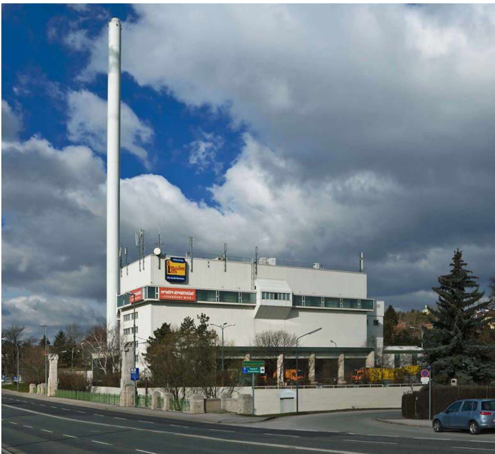
Abbildung 2.4.: MVA Flötzersteig Copyright Wien Energie Fernwärme/ Hubert Dimko
