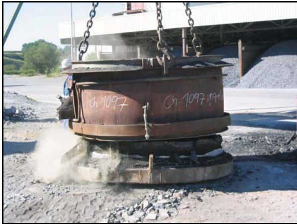
Abbildung 63: Abheben der Ofenwand
