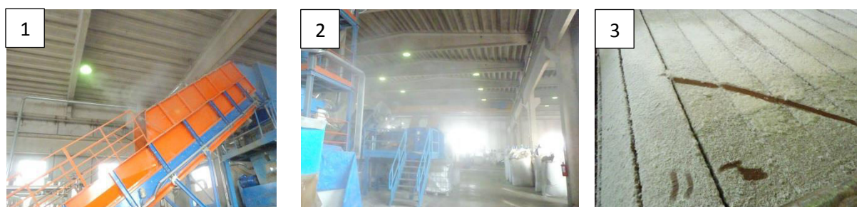
Abbildung 100: Staubentwicklung in Anlage während Zerkleinerung von MG4, MG5, MG6 (3 Bilder)
