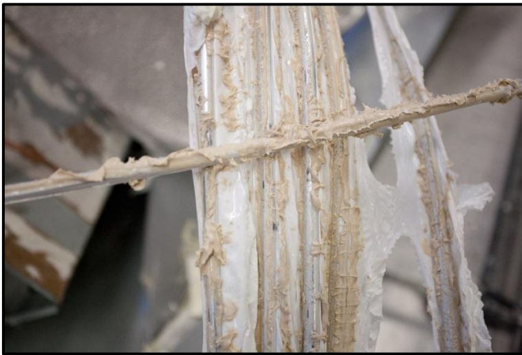
Abbildung 21: Wärmeleitpaste und Kunststoffolie an den Innenrohren
