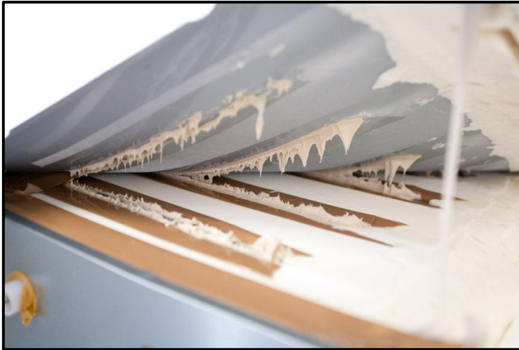
Abbildung 19: Abheben der äußeren Stahlblechhülle
