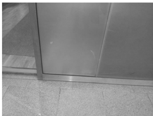
Abbildung 13: Glaswand mit Folie sichtbar gemacht 67
