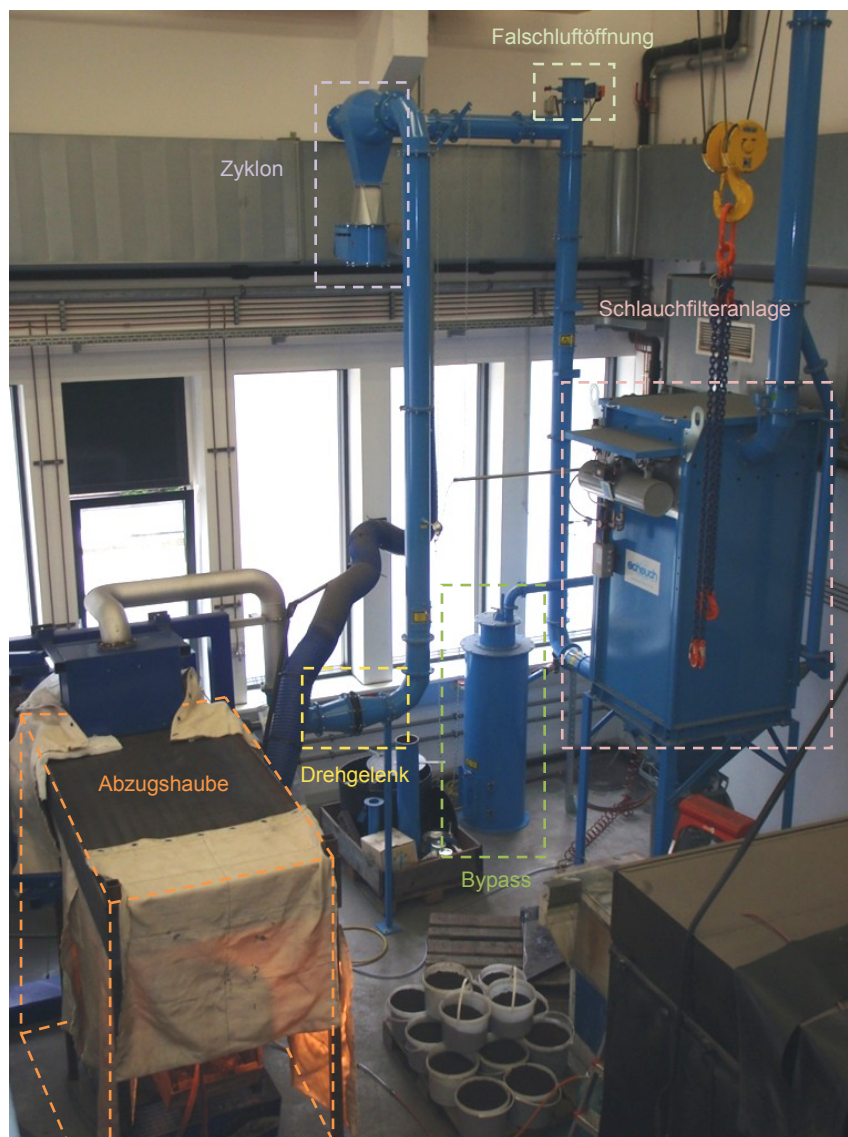
Abbildung 6-2: Versuchsanlage mit geschlossenem Abzugssystem an der Montanuniversität Leoben
