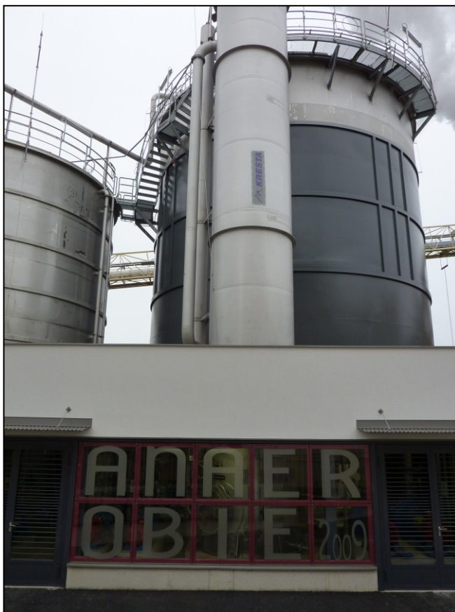
Abbildung 10: Sicht auf Reaktor, Konditionierungstank, Bleichereiabwassertank und Dosiergebäude [9]
